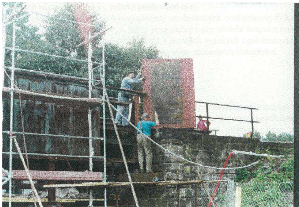
Výměna části stěny u OK 2
