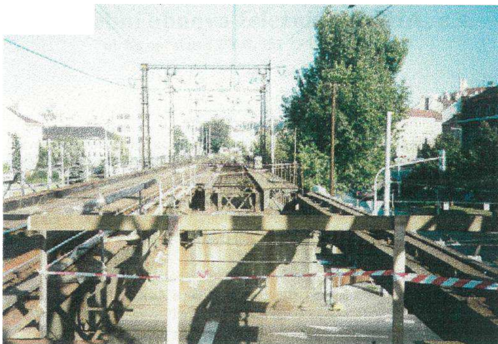
Celkový pohled na most v km 3,545 trati Praha hl.n. - Praha Smíchov
