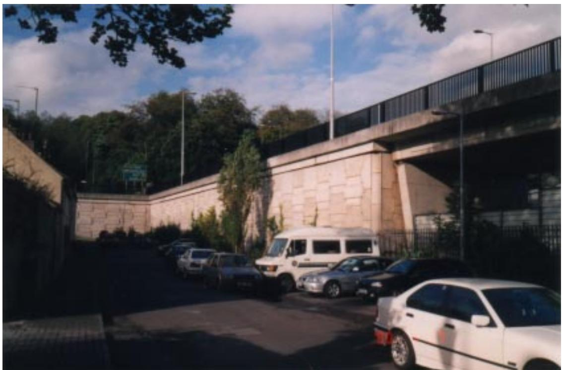
Obr. 4 Pohled na 2 mostní opěry z vyztužené zeminy v Irsku.
