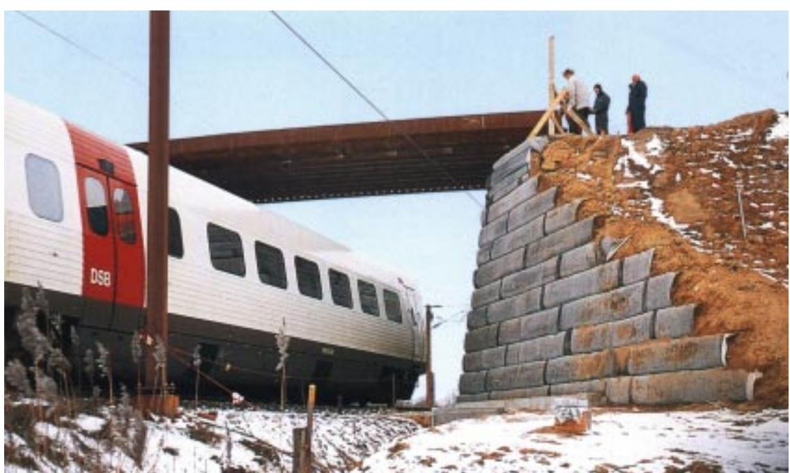
Obr. 3b Silniční most nad železniční tratí s opěrami z vyztužené zeminy v Dánsku.
