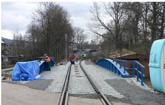
Obr. 13 Železniční svršek na mostě
