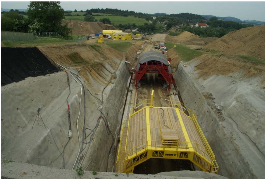
Obr. 1 Svahovaná stavení jáma Olbramovického tunelu – výjezdový portál
