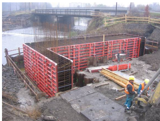
Obr. 2 Bednění dříků opěr
