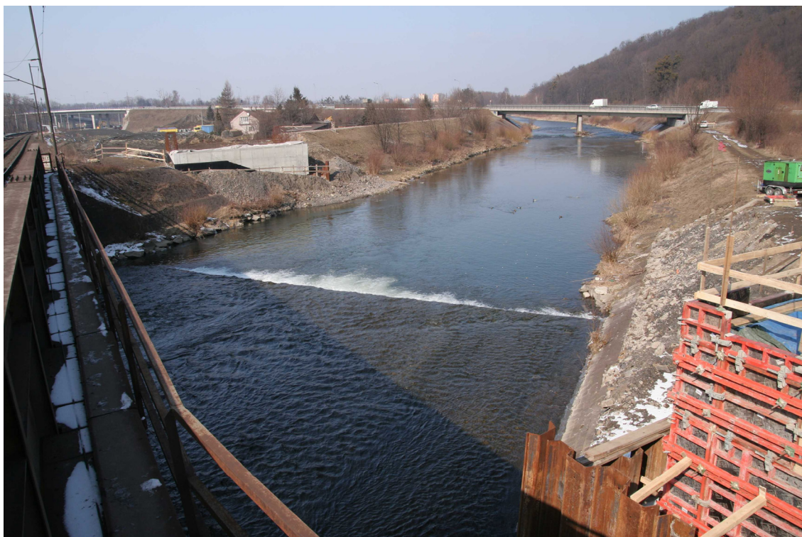
Obr. 2 Pohled na opěru z původního mostu
