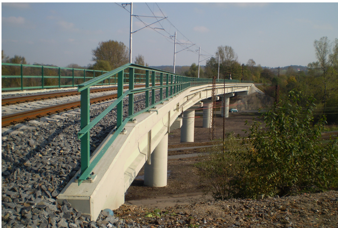
Obr. 1 most po rekonstrukci
