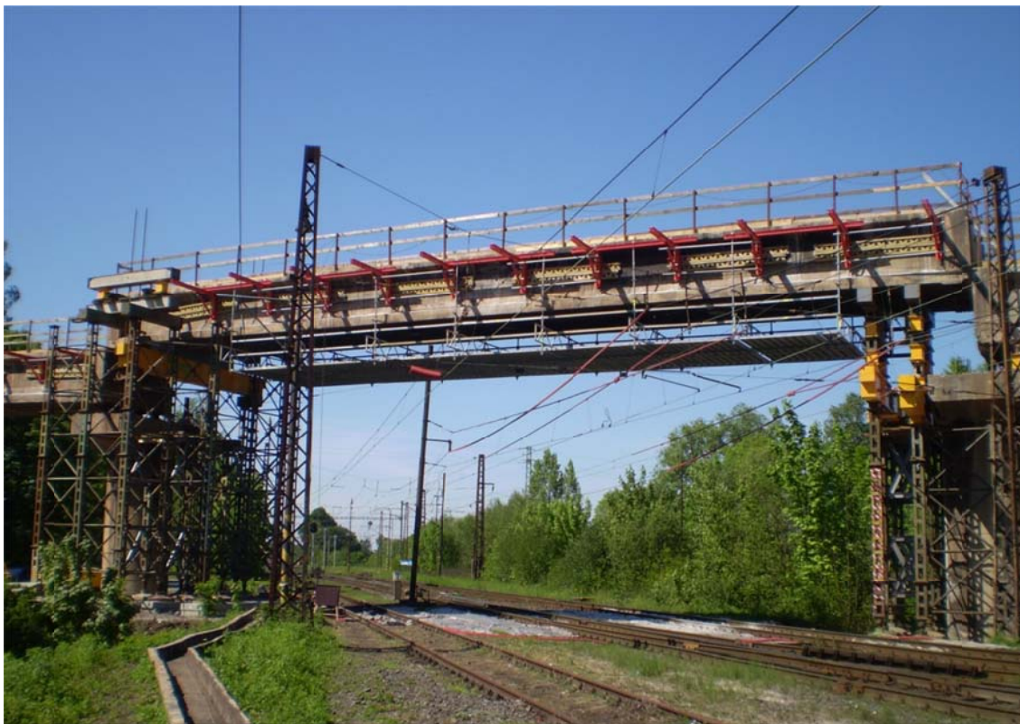
Obr. 3 Fáze zvednutí pole nosné konstrukce nad tratí Český Těšín – Dětmarovice
