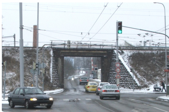
Obr. 2 Pohled na původní most
