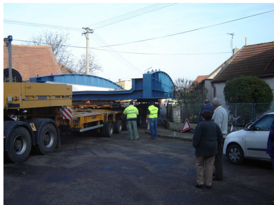
Obr. 10 Převážka NK mostu
