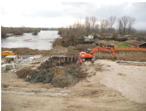
Obr. 6 a 7 Stavební jáma pro základ příbřežního pilíře P3
