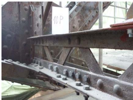
Obr. 7 Dolní příčné ztužení po opravě
