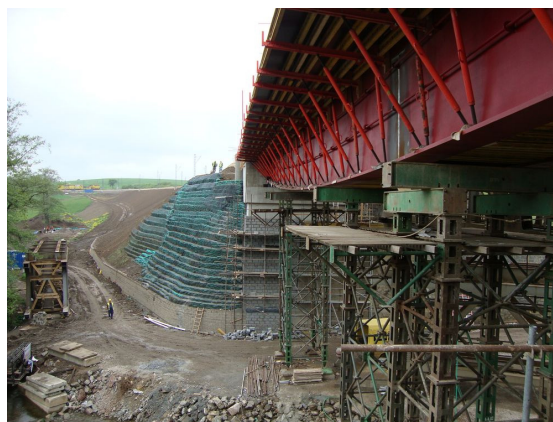
Obr. 9 Těleso z armovaných zemín, opěra O2 a NK před betonáží
