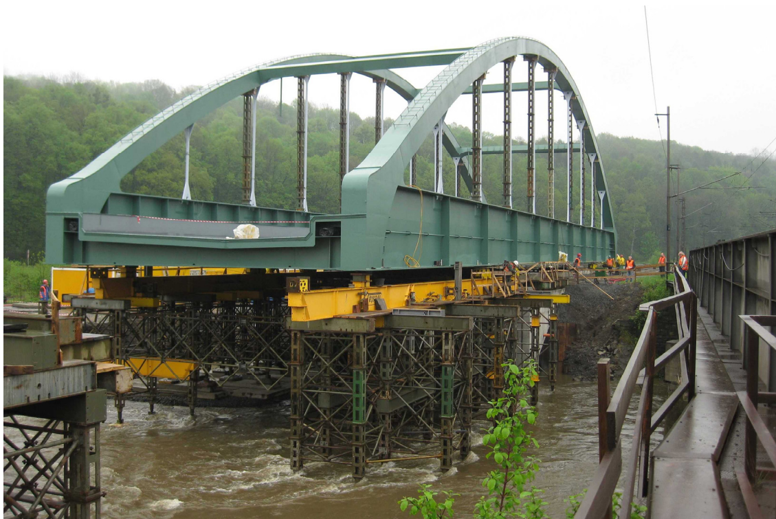
Obr. 6 Výsuv OK nad rozvodněnou řekou
