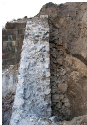
Obr. 22 Charakter zdiva a rovnaniny za křídlem
