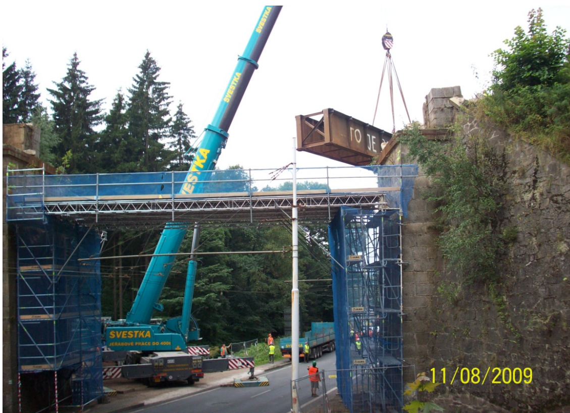
Obr. 6 Demontáž původní konstrukce
