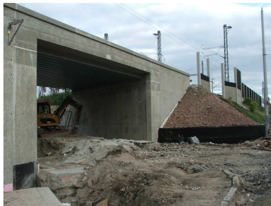
Obr. 13 Již zasypané křídlo
