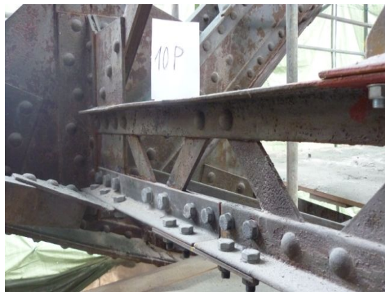
Obr. 7 Dolní příčné ztužení po opravě
