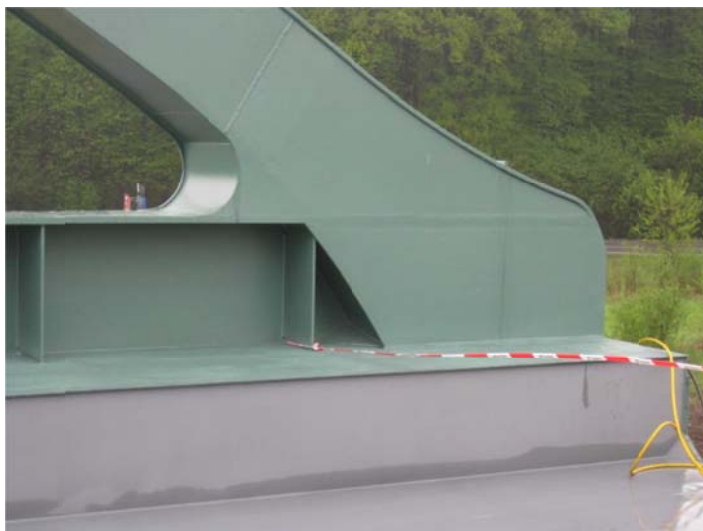
Obr. 5 Napojení oblouku na trám
