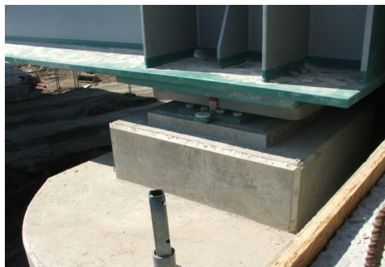
Obr. 12 Osazené ložisko
