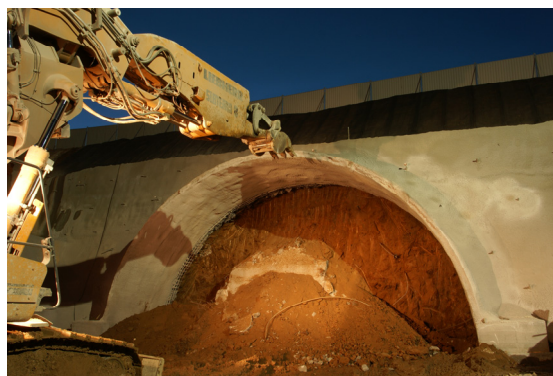
Obr. 3 Vjezdový portál Olbramovického tunelu se zcela zvětralým eluviem a minimálním nadložím
