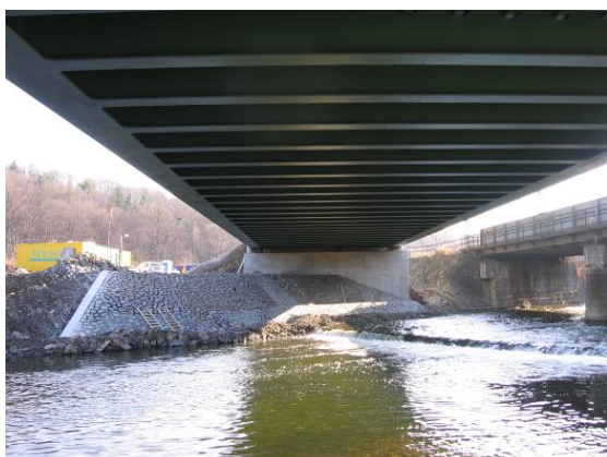
Obr. 9 Pohled na bystřickou opěru
