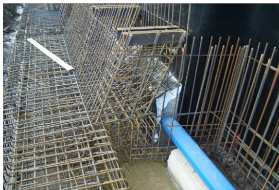
Obr. 20 Boční drenáž po vyztužení patek
