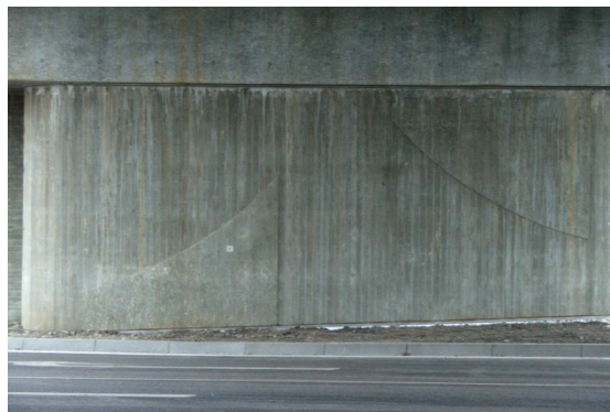
Obr. 8 Pohled na profilování dezénu na opěře
