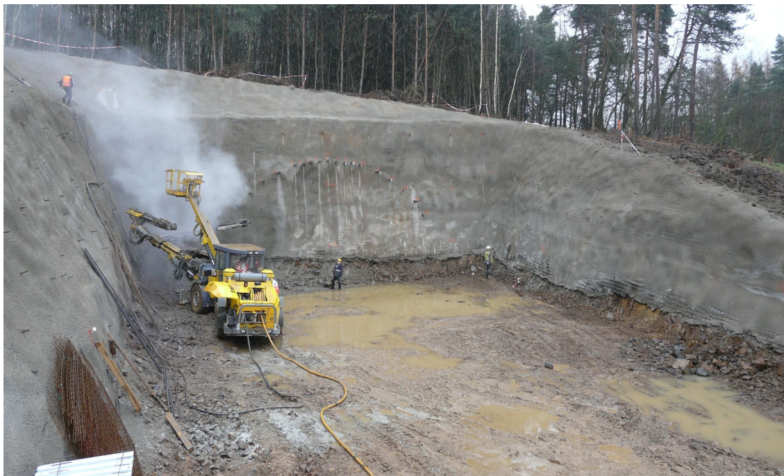
Obr. 1 Pohled na jižní vjezdový portál
