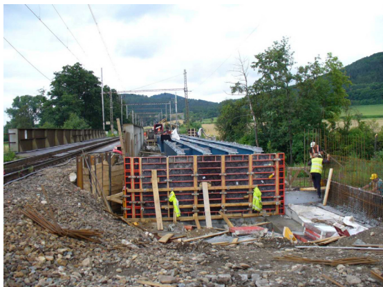
Obr. 1 Výstavba mostu v koleji č. 1
