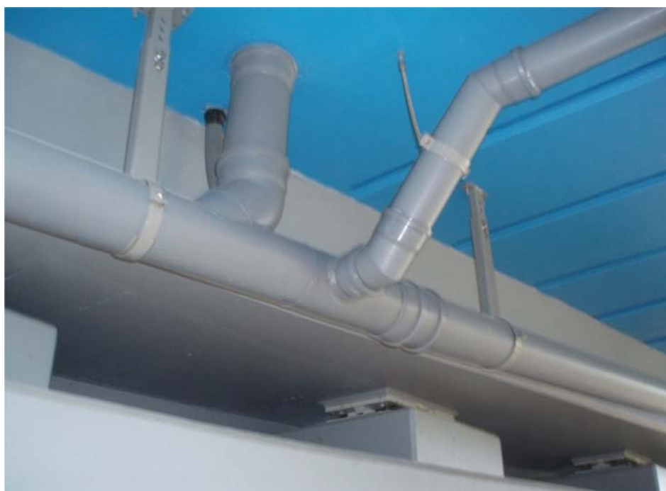
Obr. 10 Univerzálnost a variabilnost potrubí PP s kompenzačním hrdlem bez spojek
