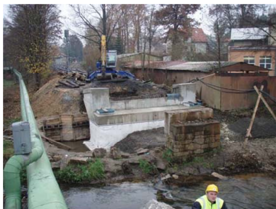
Obr. 8 Nová opěra vs. původní pilíř
