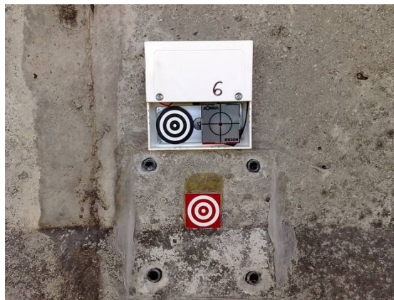
Obr. 6 Detail měřické značky na mostovce
