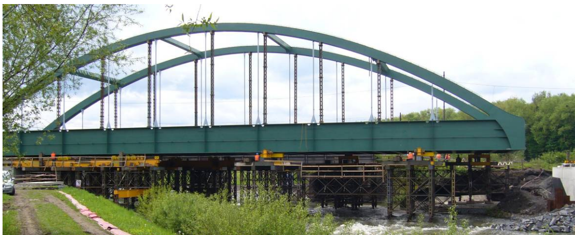
Obr. 6 Výsun konstrukce
