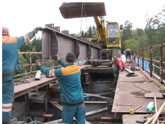
Obr. 11 Osazování podélníků
