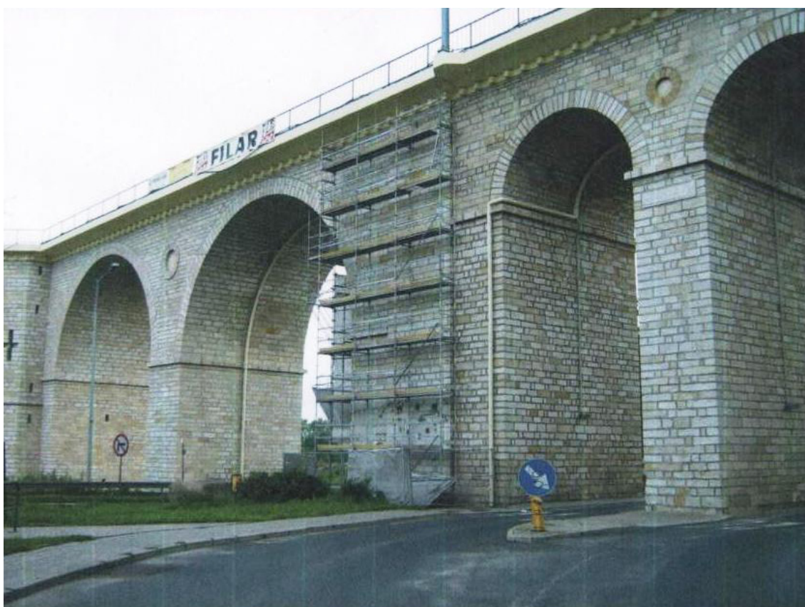
Obr. 8 Stav odvodnění mostu po rekonstrukci
