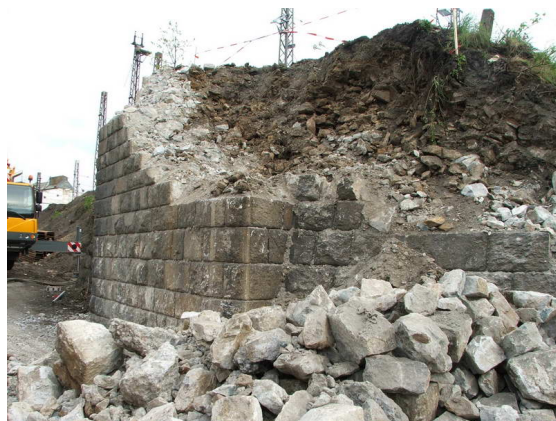
Obr. 4 Demolice kamenné opěry
