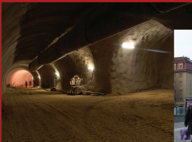
Pražské metro - přístupová štola, místo pro otáčení mechanismů
