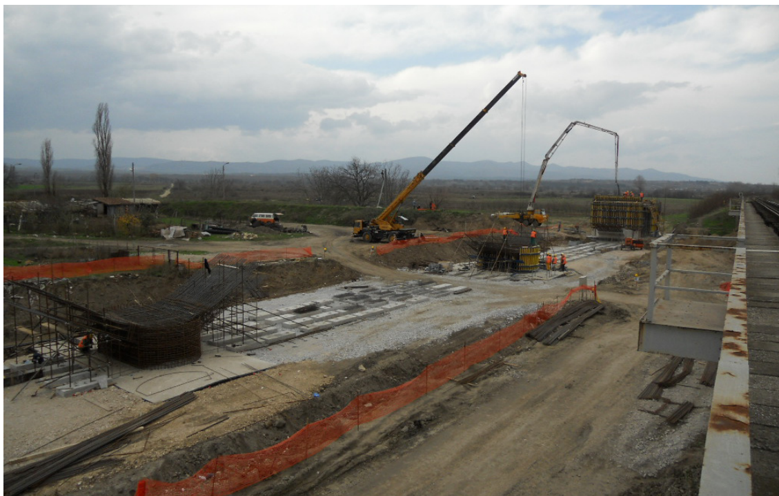
Obr. 8 Pohled na výstavbu pilířů P2, P1 a opěry AB1
