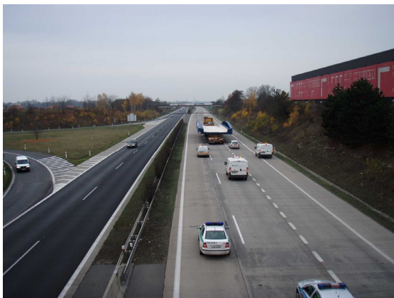
Obr. 11 Přeprava NK mostu (dálnice D11)
