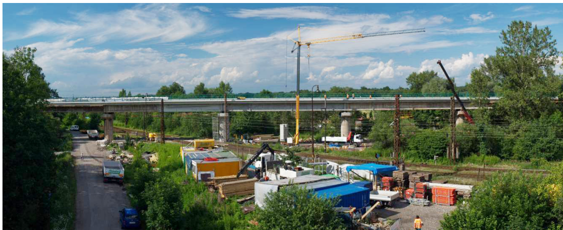
Obr. 1 Most „Gagarin“ po rekonstrukci
