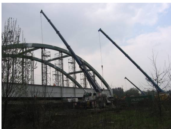
Obr. 3 Montáž OK mostu
