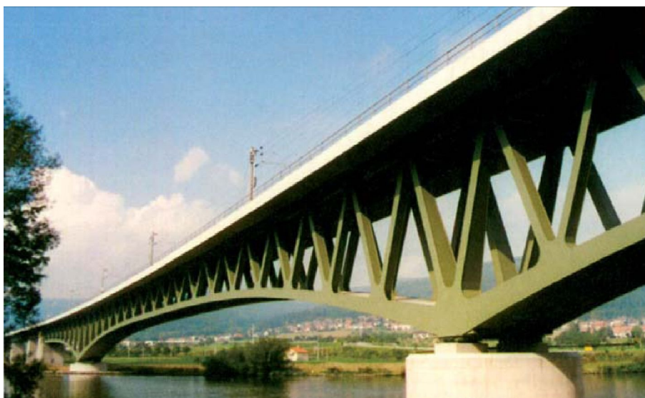
Obr. 10 Železniční most přes Mohan u Nantenbach (1994)
