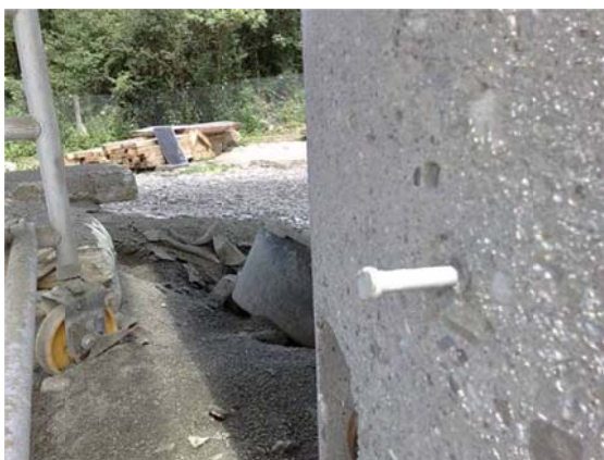
Obr. 5 Detail výškové měřické značky na podpěře
