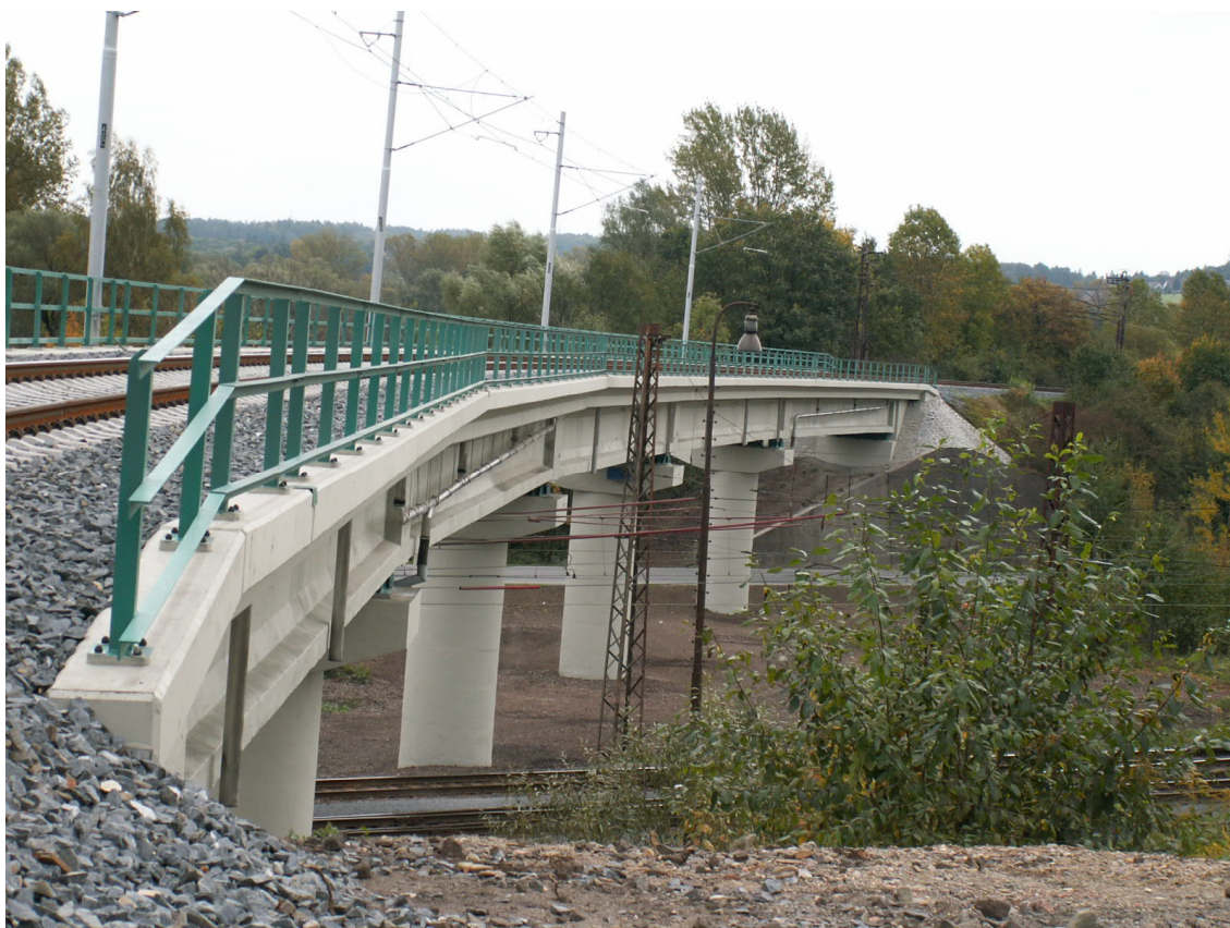
Obr. 1 Nový stav mostu
