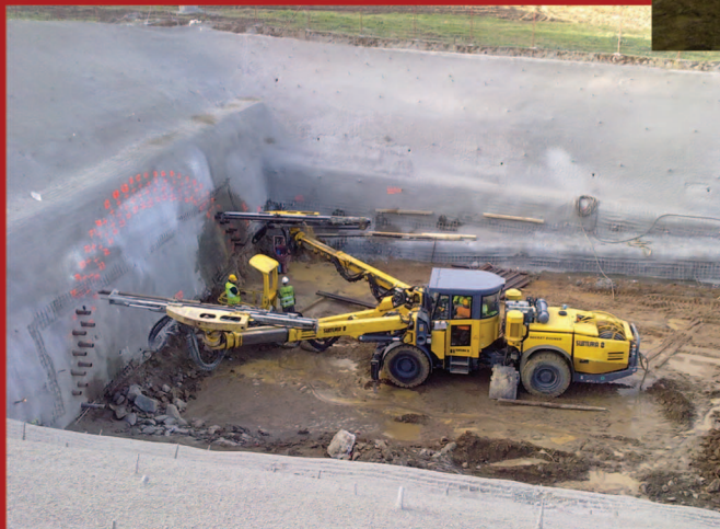
Železniční tunel Zahradnický, portál - vrtání mikropilot
