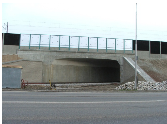
Obr. 29 Pohled z Nádražní ulice
