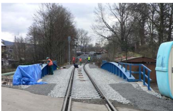
Obr. 13 Železniční svršek na mostě
