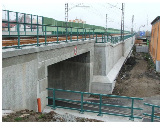
Obr. 15 Navazující opěrná zeď
