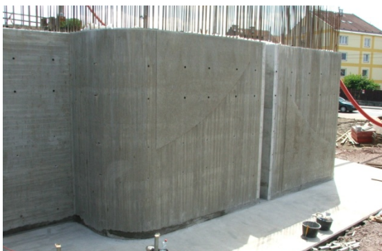
Obr. 5 Pohled na dřívě opěry s profilací
