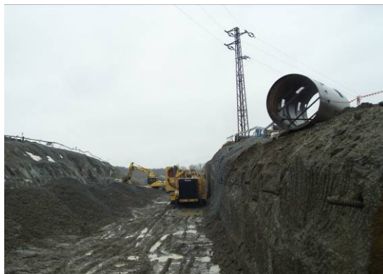
Obr. 18 Fréza pod stožárem vysokého napětí
