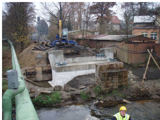
Obr. 8 Nová opěra vs. původní pilíř
