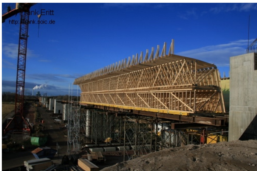
Obr. 7b Most přes údolí Sály a Elstery – zahájení výstavby nosné konstrukce (2007)
