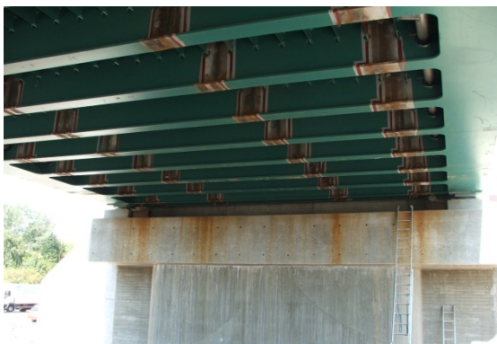
Obr. 13 Dokončená montáž OK mostu
