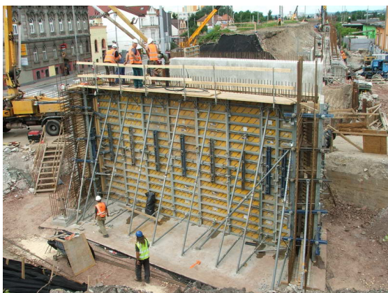
Obr. 8 Bednění opěry
