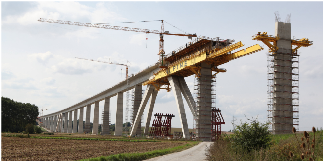
Obr. 9 Most přes údolí řeky Unstrut – výstavba mostu (2010)
