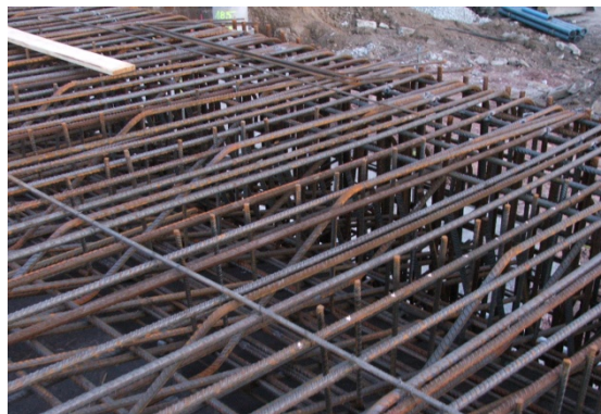
Obr. 25 Vyztužení příčle polorámu
