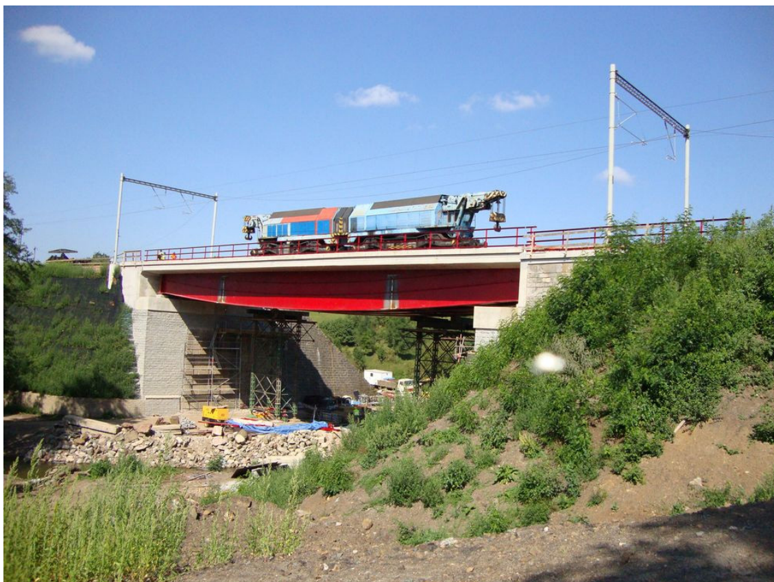
Obr. 10 Zatěžovací zkouška 2. NK
