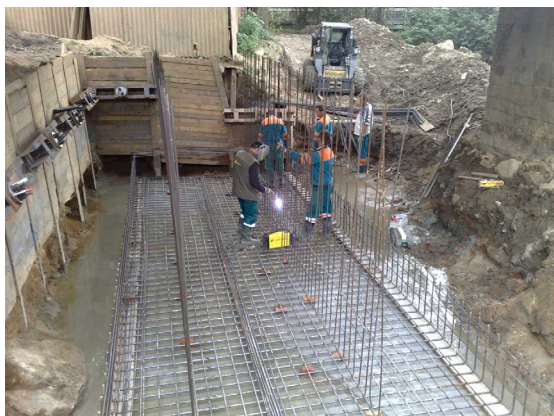
Obr. 7 Výstavba opěry pod MP
