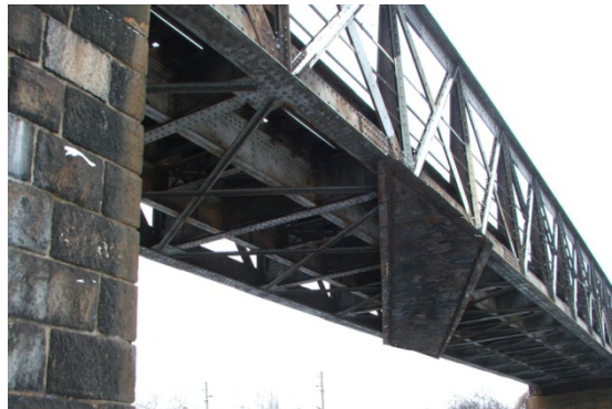
Obr. 19 Původní nosná konstrukce
