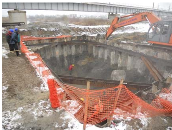
Obr. 6 a 7 Stavební jáma pro základ příbřežního pilíře P3
