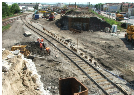
Obr. 21 Pohled na částečnou demolici a pažení
