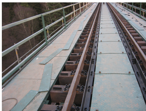
Obr. 9 Po montáži koleje, PÚ a podlah
