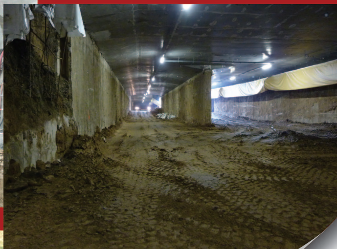
Pražský okruh - hloubené silniční tunely u stanice Hradčanská
