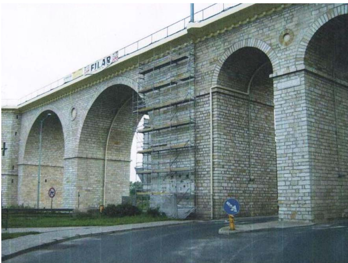
Obr. 8 Stav odvodnění mostu po rekonstrukci
