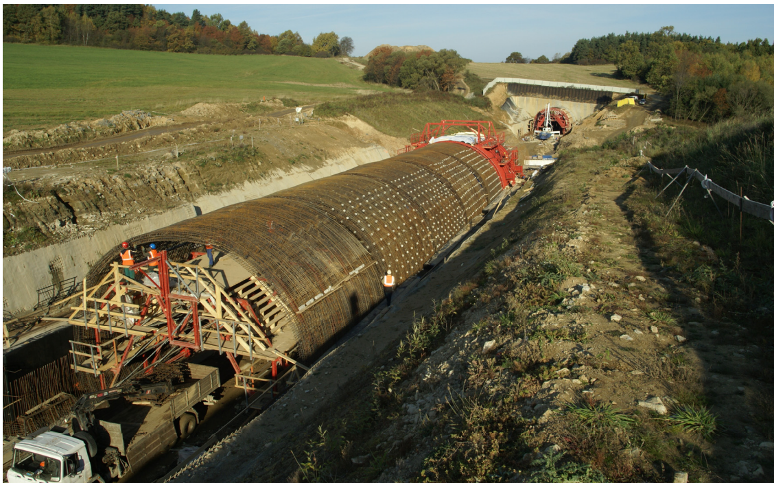
Obr. 1 Výztuž ostění Votického tunelu – vzadu portál Olbramovického tunelu
