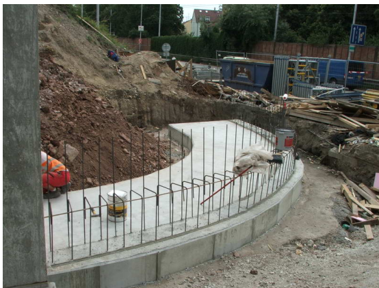
Obr. 12 Základ křídlové zídky Z1
