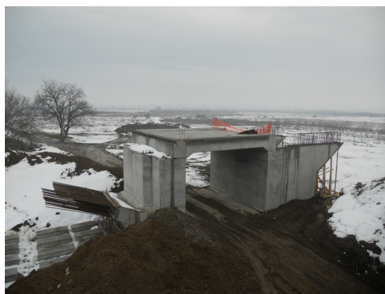
Obr. 9 a 10 Betonáž a odbedněný kubus opěry AB1 se zárodkem oblouku
