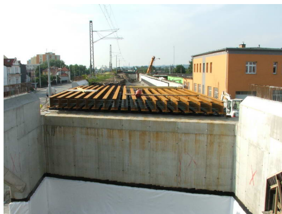
Obr. 9 Osazení nosníků
