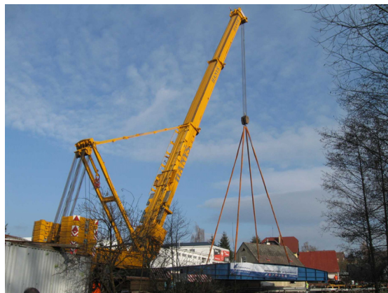
Obr. 12 Ukládání NK mostu na opěry
