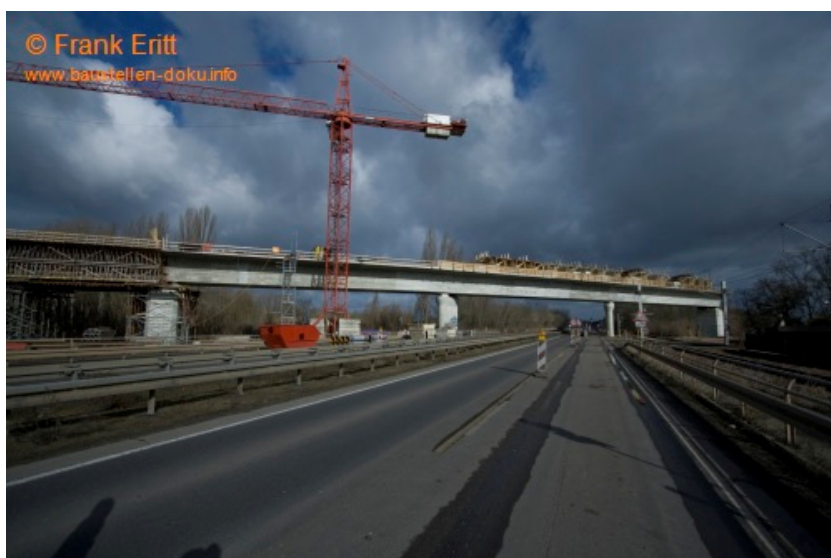
Obr. 7c Most přes údolí Sály a Elstery – pohled na část vybetonované nosné konstrukce (2010)
