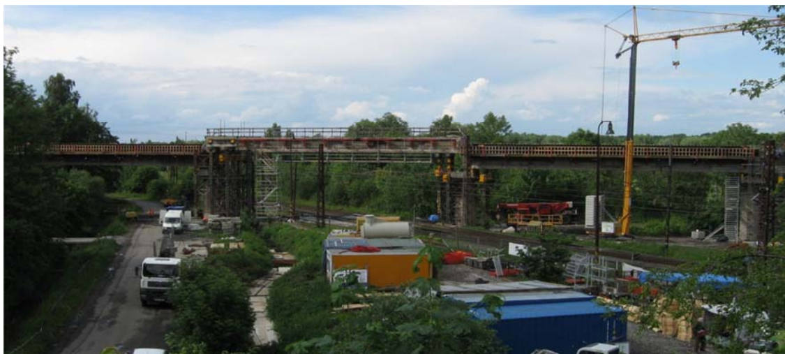
Obr. 2 Celkový pohled na staveniště v průběhu výstavby
