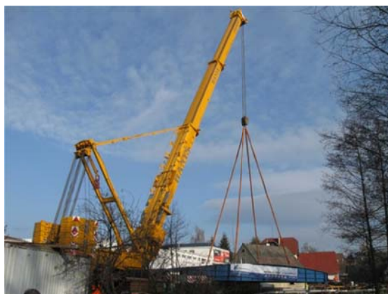
Obr. 12 Ukládání NK mostu na opěry
