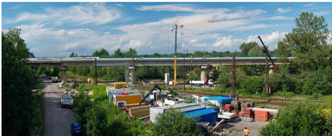
Obr. 1 Most „Gagarin“ po rekonstrukci
