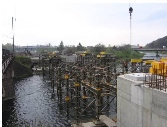
Obr. 4 Montáž vysouvací dráhy
