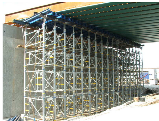
Obr. 11 Podepření nosníků při výstavbě
