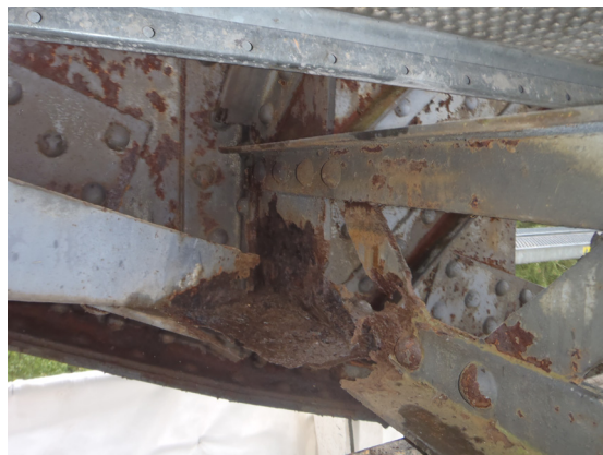
Obr. 3 Dolní příčné ztužení
