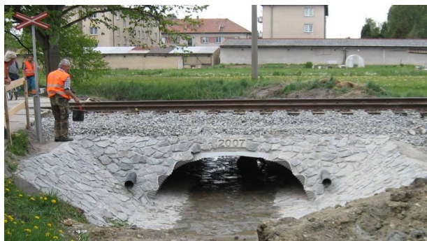
km 39,085 trati Heřmanův Městec - Borohrádek (Holice) Super Cor 3,17m x 1,18m
