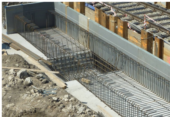
Obr. 24 Základ polorámu s opěrným bodem
