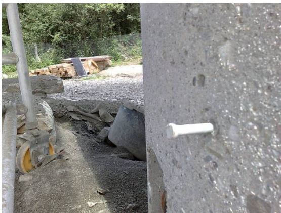
Obr. 5 Detail výškové měřické značky na podpěře
