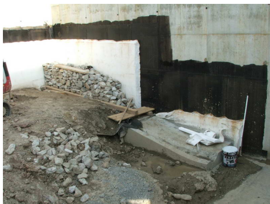
Obr. 10 Izolace rubu opěry
