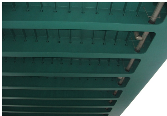
Obr. 14 Dokončená montáž OK mostu včetně PKO
