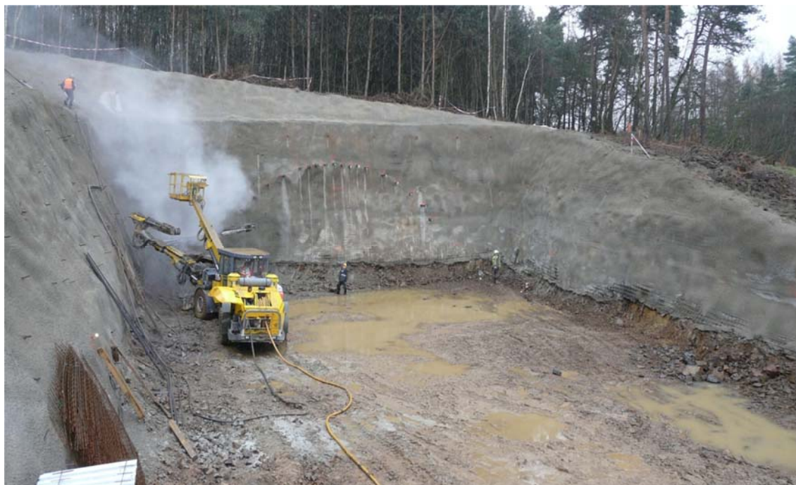
Obr. 1 Pohled na jižní vjezdový portál
