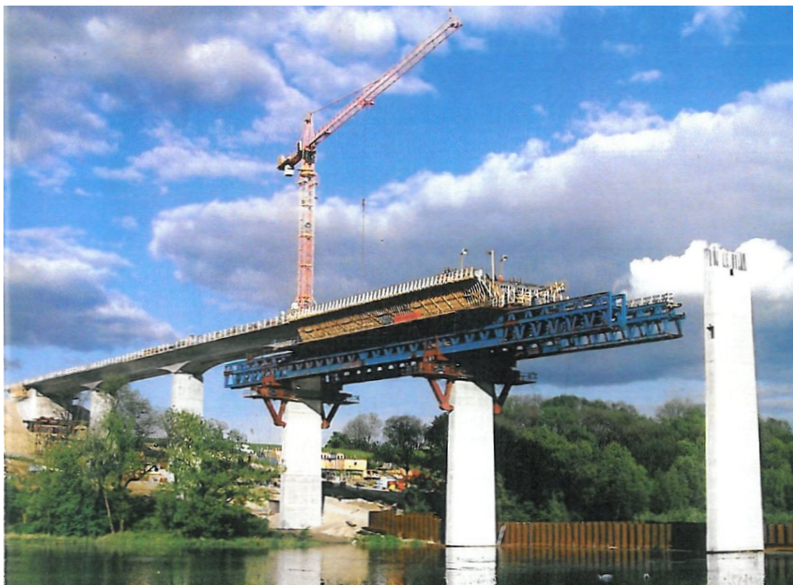
Obr. 8a Most přes údolí řeky Scherkonde - výstavba nosné konstrukce (2008)
