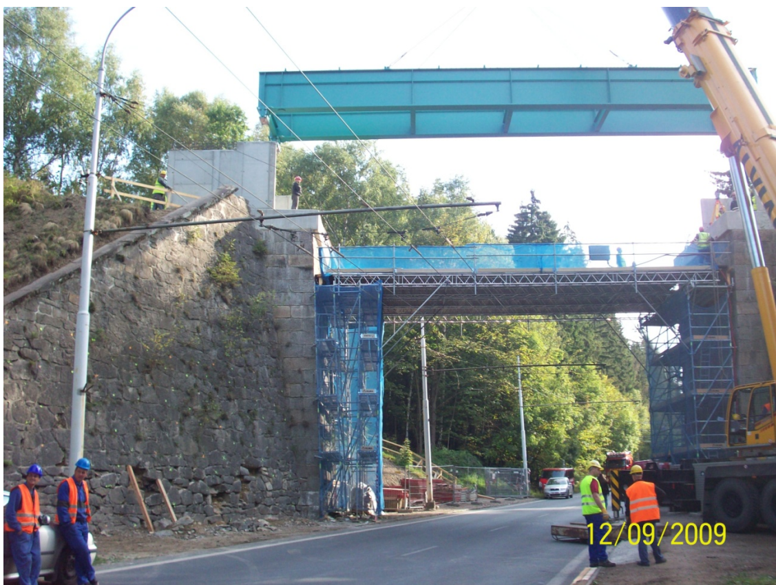
Obr. 9 Montáž nové konstrukce
