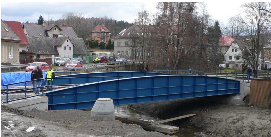
Obr. 15 Téměř dokončený most
