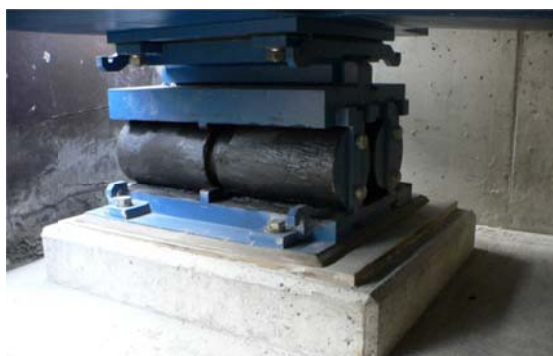
Obr. 14 Ocelové dvouválcové ložisko 2VS-3
