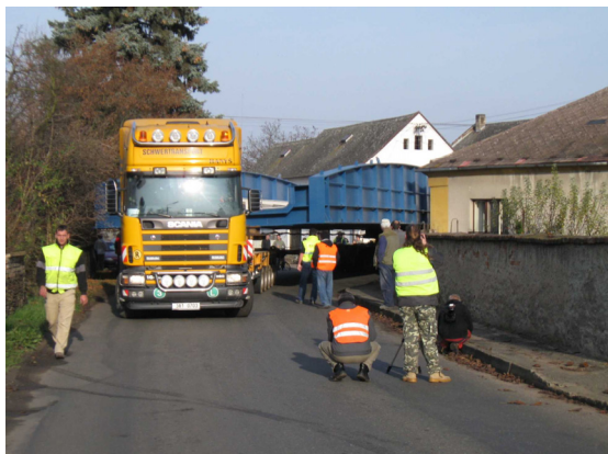
Obr. 9 Vypravení NK mostu z mostárny
