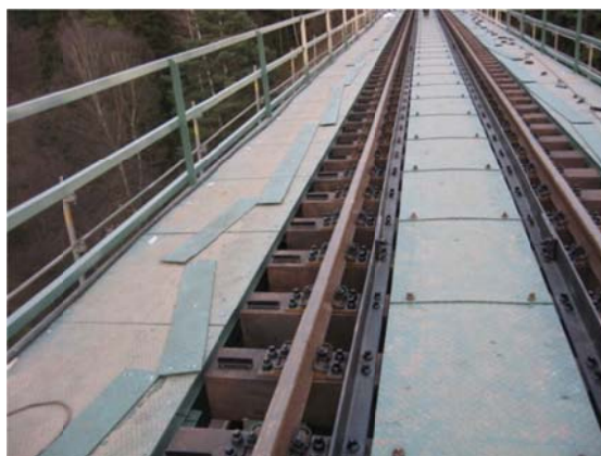
Obr. 9 Po montáži koleje, PÚ a podlah
