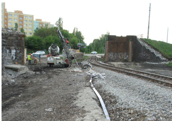
Obr. 20 Trysková injektáž pod základy polorámu
