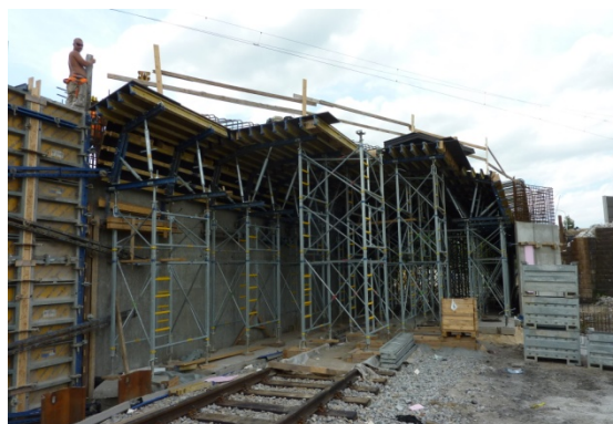
Obr. 27 Podskružení příčle polorámu
