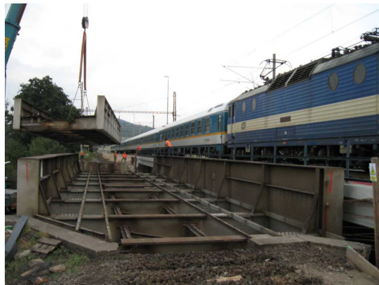
Obr. 2 Snášení původních OK v koleji č. 2
