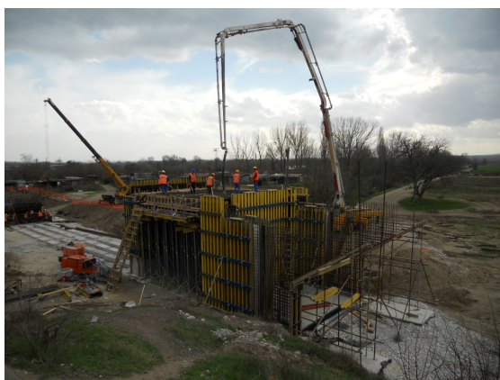
Obr. 9 a 10 Betonáž a odbedněný kubus opěry AB1 se zárodkem oblouku
