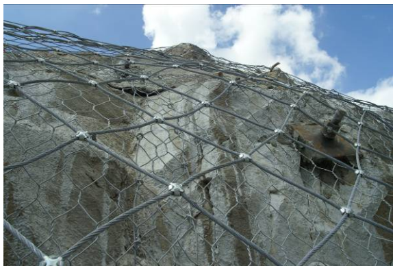
Obr. 15 Stabilizace svahu HEA panely
