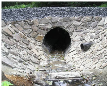
km 167,001 trati Vojkovice- Ostroh nad Ohří Hel-Cor Trenchcoat DN800
