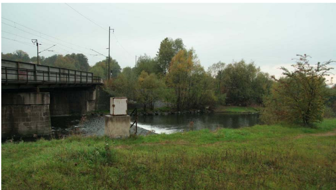
Obr. 1 Místo stavby, vlevo původní most
