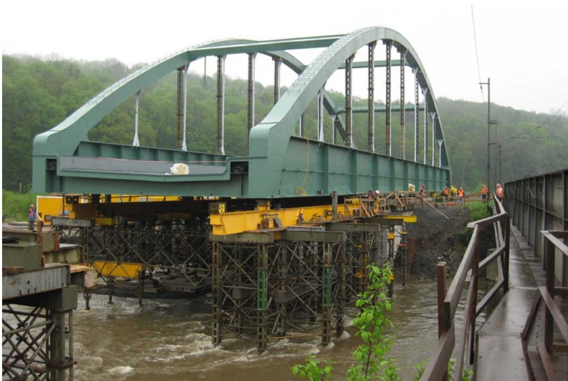
Obr. 6 Výsun OK nad rozvodněnou řekou
