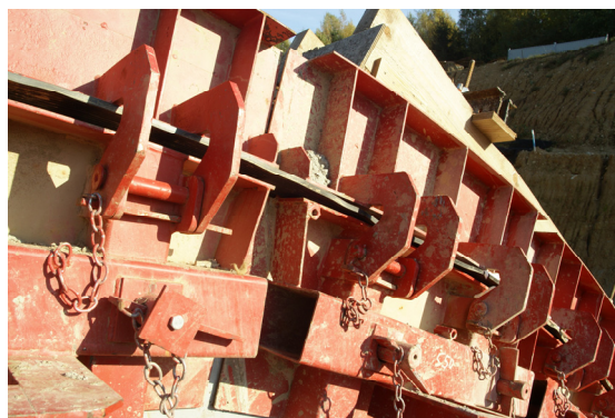
Obr. 6 Detail čela s vloženým těsnícím pásem pro utěsnění spáry mezi bloky betonáže
