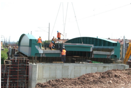
Obr. 9 Osazování dílců OK mostu
