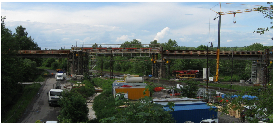
Obr. 2 Celkový pohled na staveniště v průběhu výstavby
