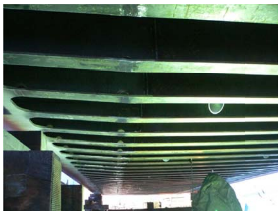
Obr. 5 Pohled zdola (příčníky)
