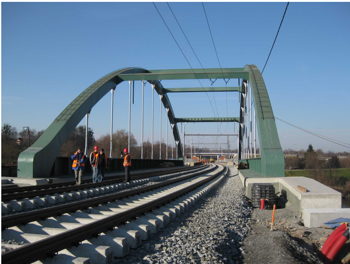
Obr. 8 Pohled do mostu těsně před dokončením
