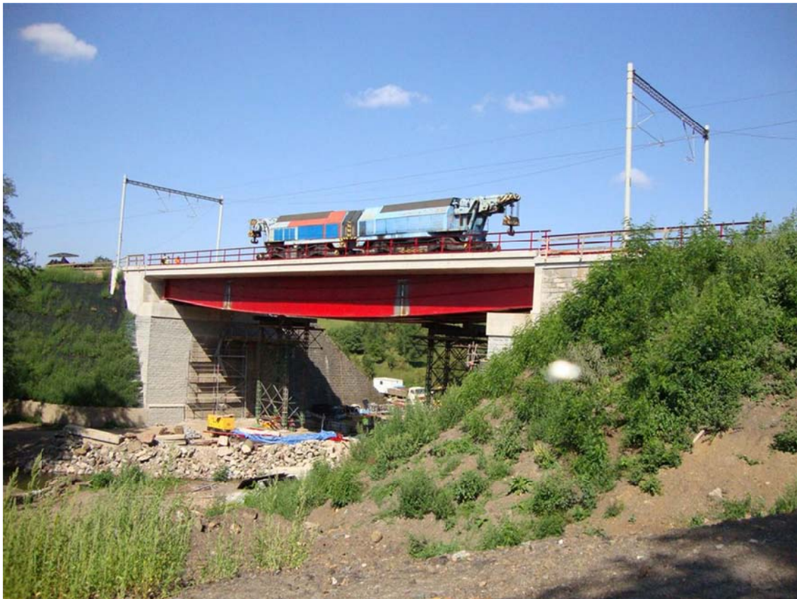
Obr. 10 Zatěžovací zkouška 2. NK
