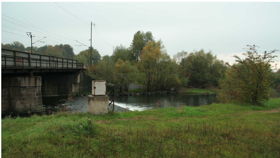
Obr. 1 Místo stavby, vlevo původní most
