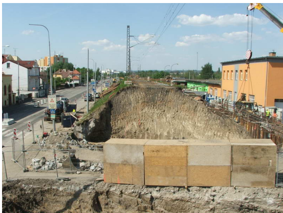
Obr. 6 Stavební jáma s krytým průchodem pro pěší
