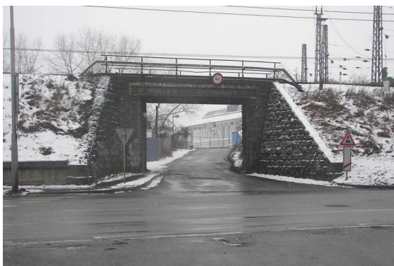
Obr. 1 Pohled na původní most
