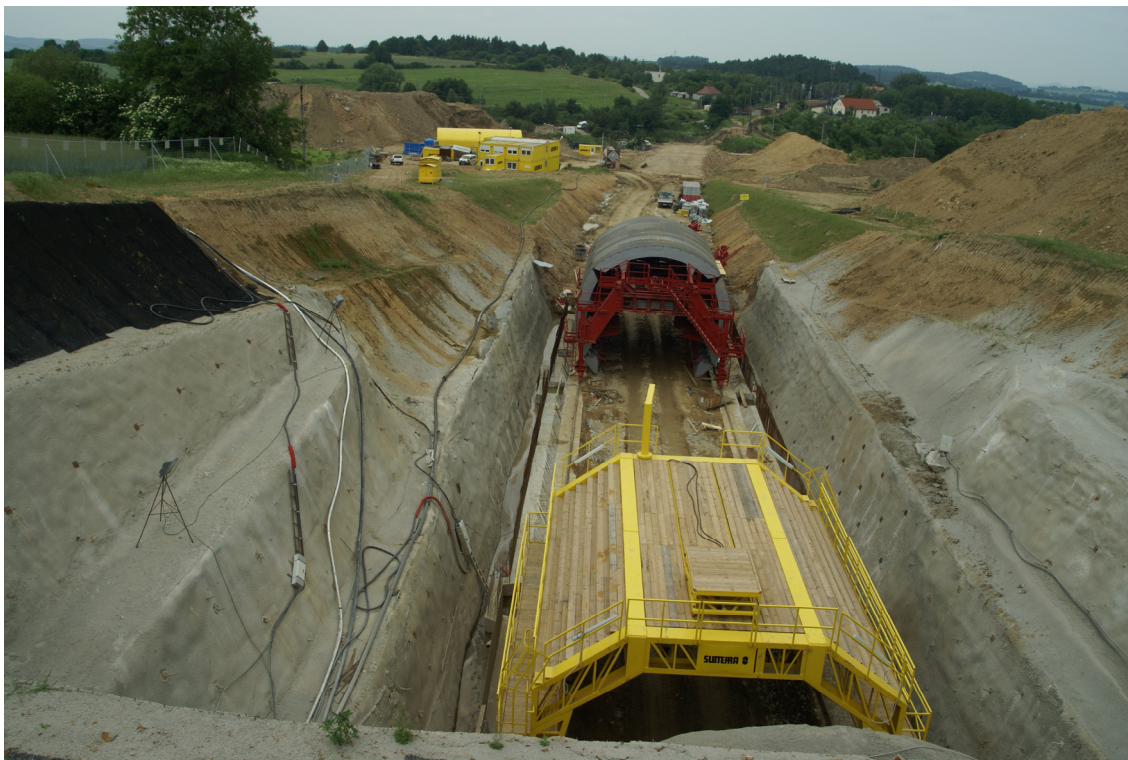
Obr. 1 Svahovaná stavení jáma Olbramovického tunelu – výjezdový portál
