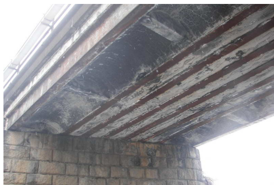
Obr. 2 Původní nosná konstrukce
