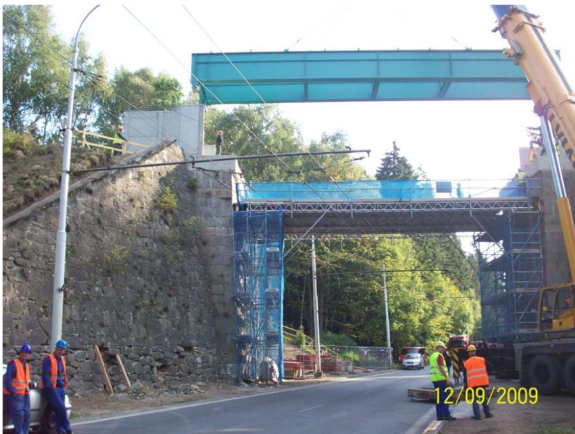
Obr. 9 Montáž nové konstrukce
