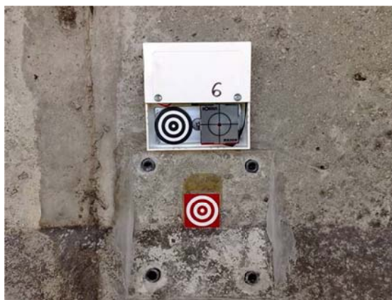
Obr. 6 Detail měřické značky na mostovce
