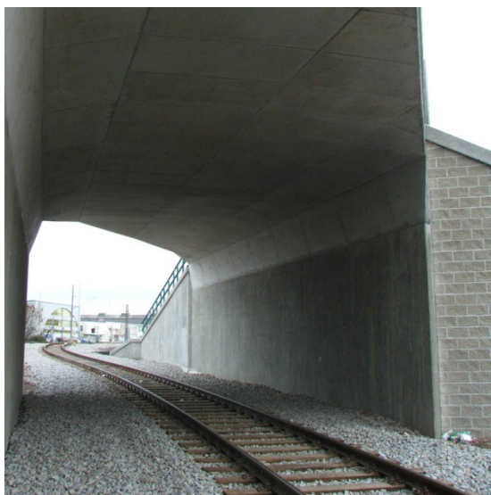
Obr. 31 Průhled směrem k pražské trati
