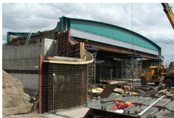
Obr. 10 Montáž OK mostu a realizace křídel
