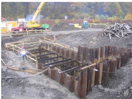
Obr. 1 Štětové jímky pro založení opěr
