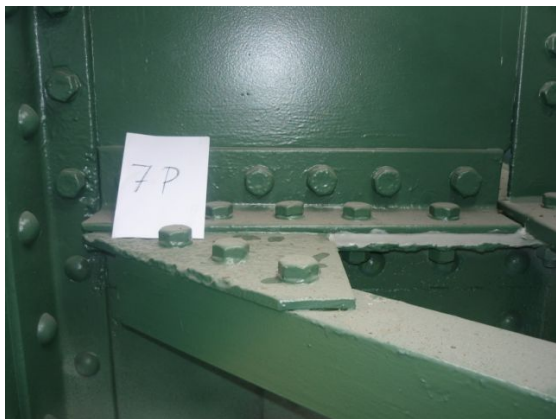
Obr. 6 Přípoj po opravě
