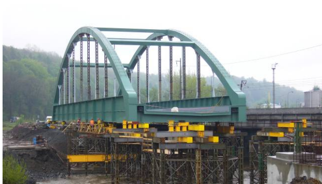
Obr. 7 Výsun konstrukce
