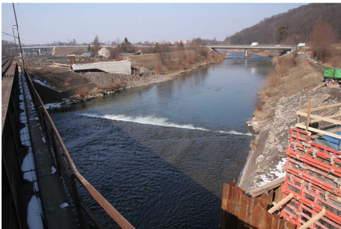
Obr. 2 Pohled na opěru z původního mostu
