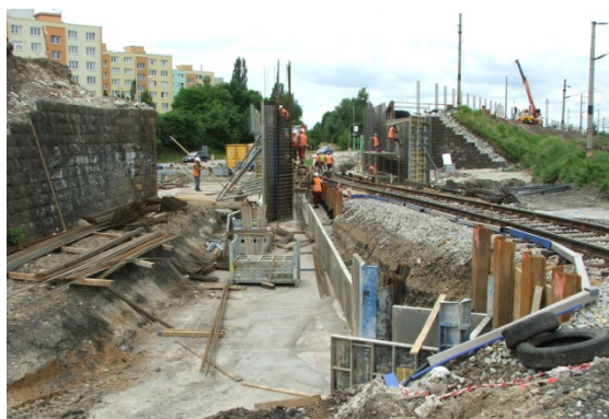
Obr. 26 Založení a stěny polorámu
