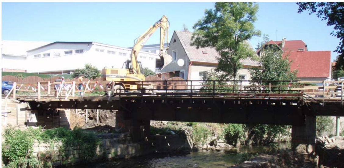
Obr. 6 Mostní provizoria v krajních polích
