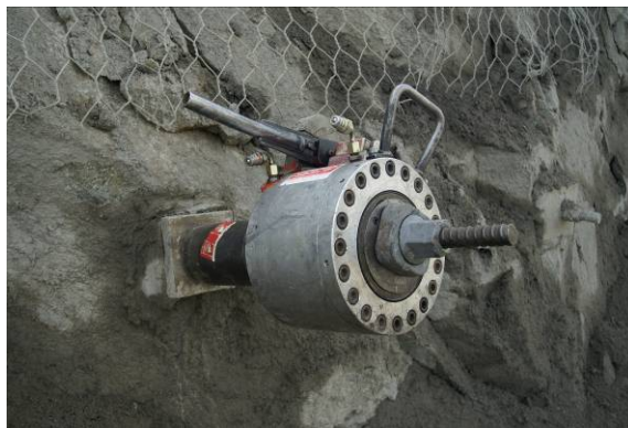
Obr. 16 Zkoušení celozávitových předpjatých kotev
