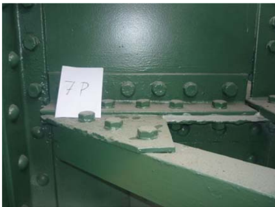
Obr. 6 Přípoj po opravě
