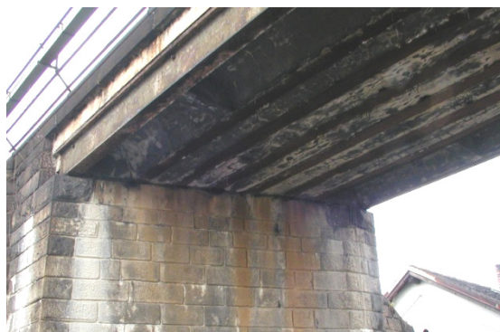
Obr. 3 Původní nosná konstrukce
