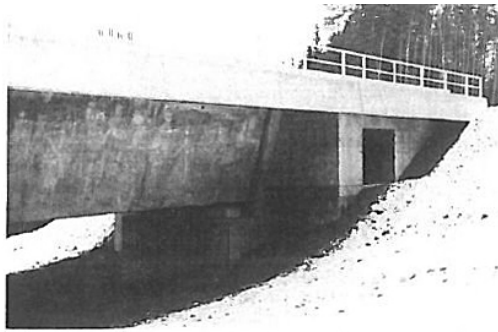
Bild 1. Widerlager mit Zufahrtsöffnung (Bauzustand)
