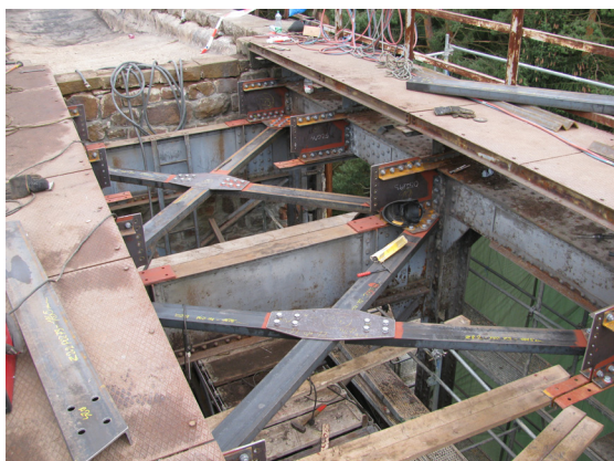
Obr. 10 Pole před osazením podélníků
