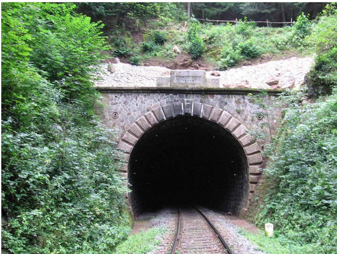
Obr. 3 Výjezdový portál po dokončení sanace
