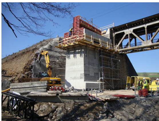
Obr. 8 Betonáž opěry O2, pažení zemního tělesa
