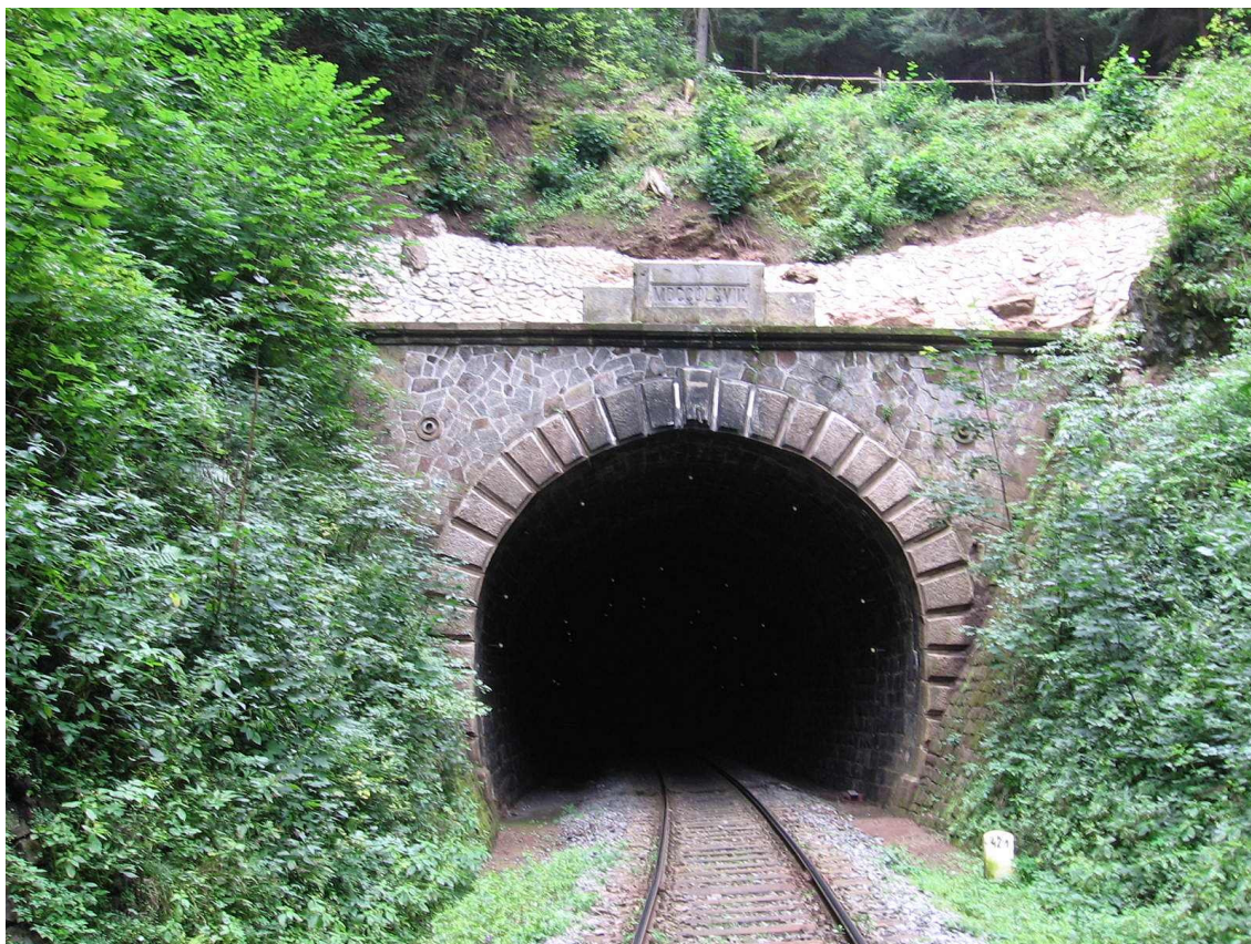
Obr. 3 Výjezdový portál po dokončení sanace
