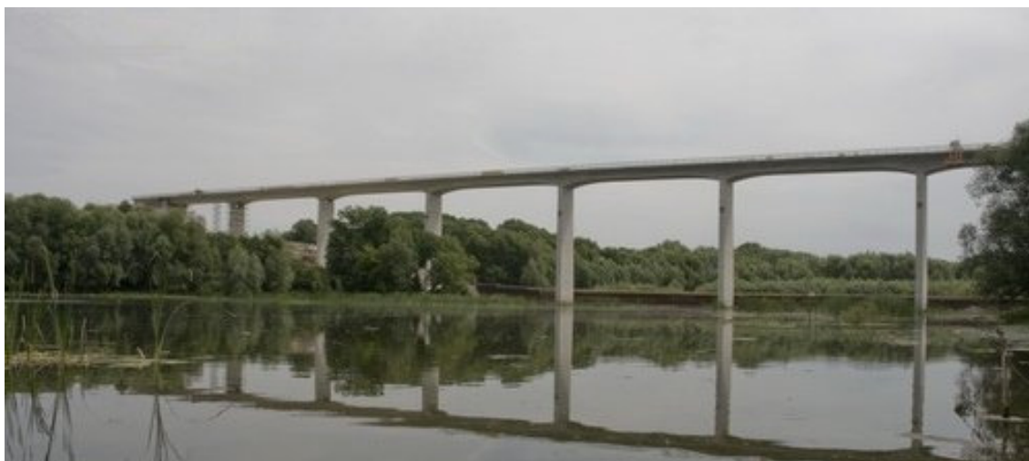
Obr. 8b Most přes údolí řeky Scherkonde - dokončená hrubá stavba (2011)
