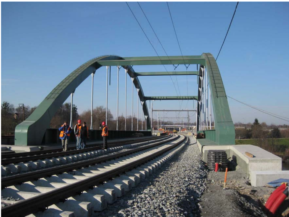
Obr. 8 Pohled do mostu těsně před dokončením
