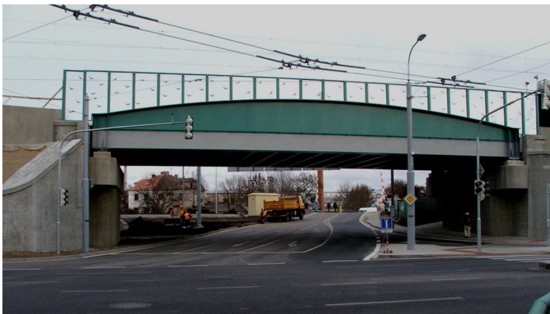
Obr. 1 Nový stav mostu
