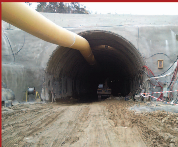
Železniční tunel Zahradnický - ražba
