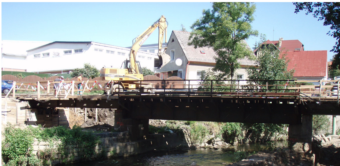
Obr. 6 Mostní provizoria v krajních polích
