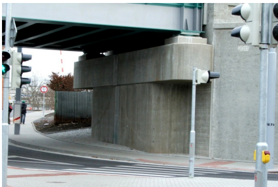
Obr. 7 Pohled na dokončenou opěru
