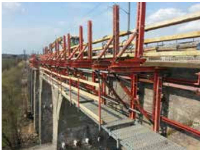
Obr. 6 - posuvné bednění pro realizaci ŽB desky
