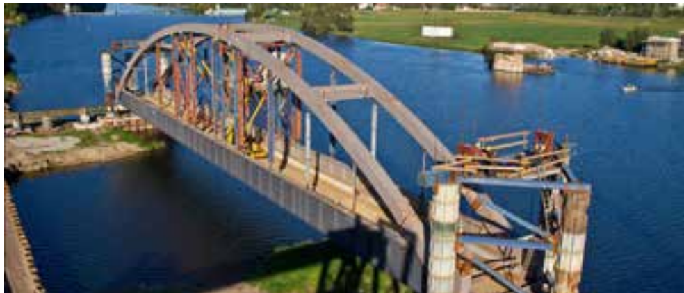
Obr. č. 9: Dočasný přístav (laguna) včetně zvedacích věží pro zavážení mostních polí
