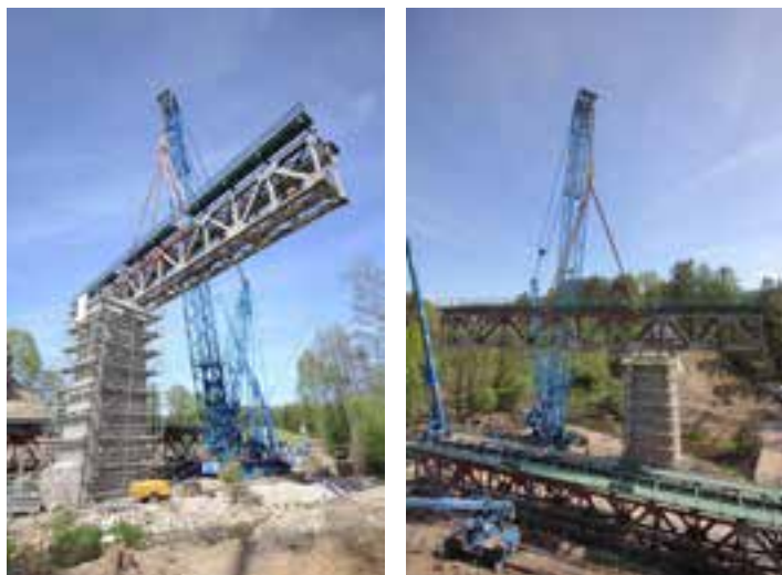
Obr. 5,6) Montáž nových ocelových konstrukcí mostu
