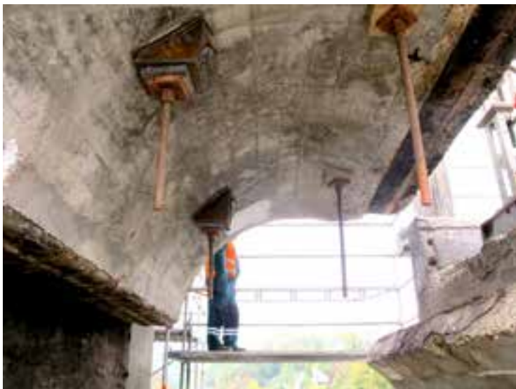
Obr. 5 – pohled vloženého pole po zvednutí
