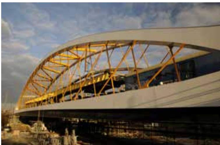
Obr. 4 – Zatěžovací zkouška mostu jeřábem GEK 80, pohled po km směr Břeclav
