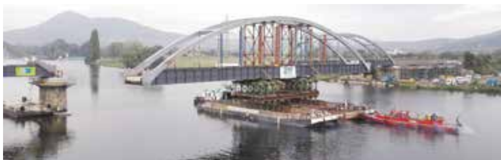
Obr. č. 7: Montáž poslední ocelové konstrukce pole č. 4
