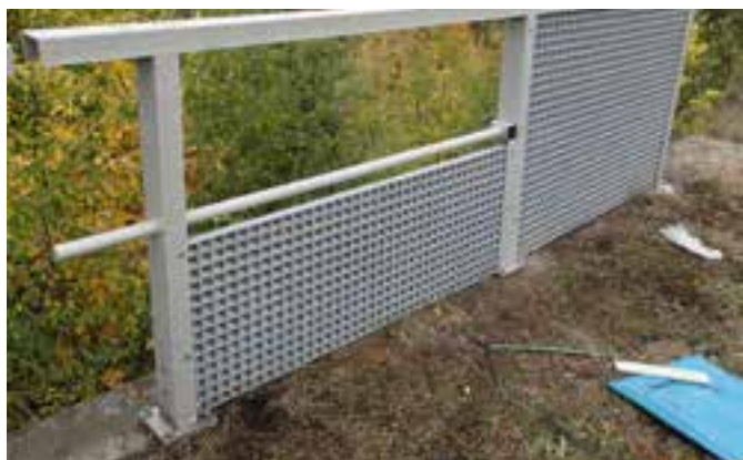
Obr. 2 Zábradlí na opěře – s výplní proti odlétajícímu šterku, detail kotevní patky
