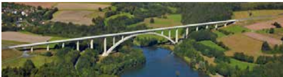
Obr. 4a: Most Froschgrundsee (Foto: Nürnberg Luftbild, Hajo Dietz)
