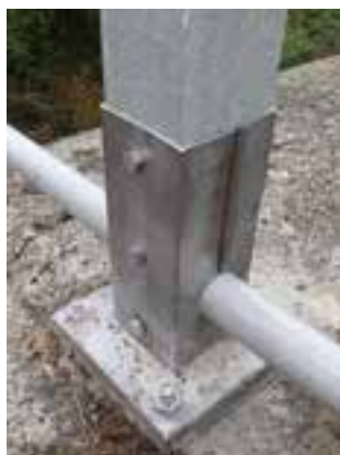
Obr. 2 Zábradlí na opěře – s výplní proti odlétajícímu šterku, detail kotevní patky
