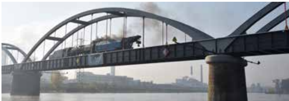
Obr. č. 8: Zatěžovací zkouška
