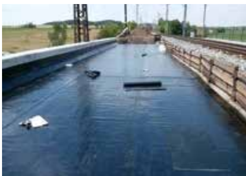
Obr. 5 – provedená izolace ŽB desky
