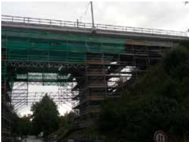
Obr. 7 - Provádění sanace betonových kleneb
