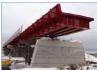
Obr. 9 Výsun NOK mostu
