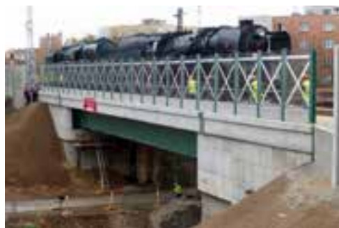
Obr. 3 Most přes Potoční ulici: pažení v koleji č. 2; zatěžovací zkouška v koleji č. 1
