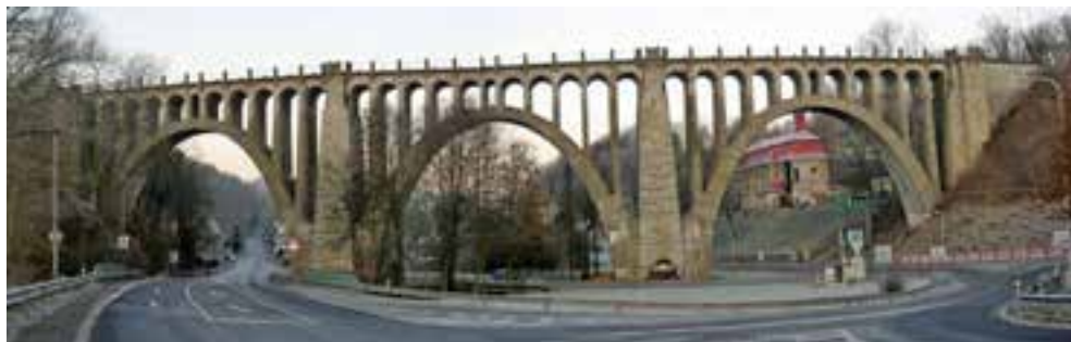
Obr. 1 – pohled na most před rekonstrukcí
