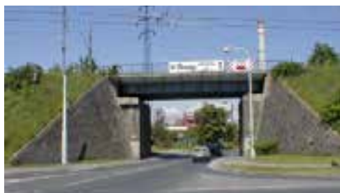
Jateční ulice km 108,352
