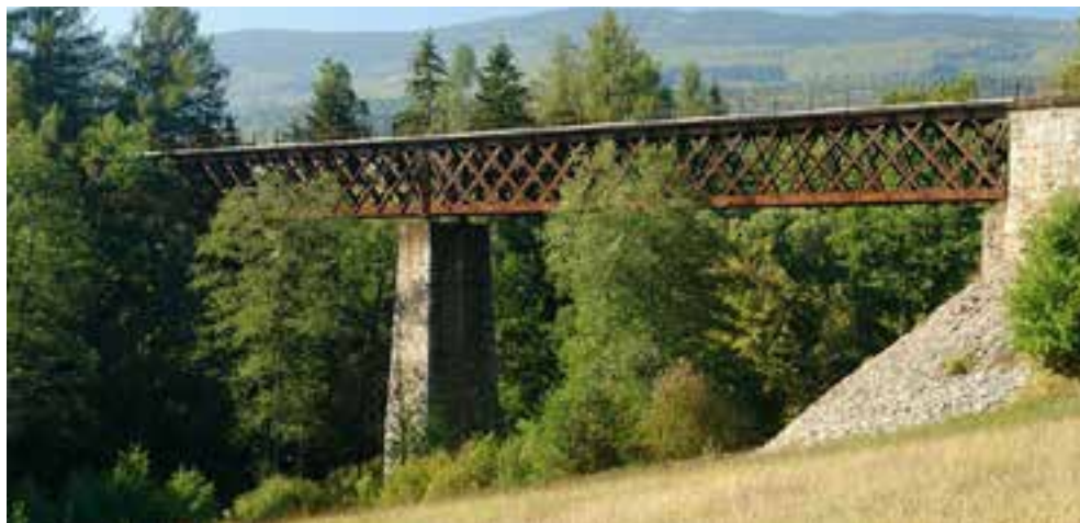
Obr. 1) původní ocelová příhradová nýtovaná spojitá konstrukce
