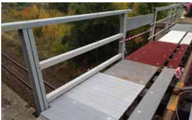
Obr. 1 Zábradlí na mostě, detail spojení ocel – FRP pomocí lepeného a předepnutého styku a celkový pohled
