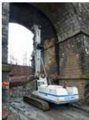
Obr. 7 Železniční most přes Úslavu: hlubinné zakládání pod stávajícími klenbami, násyp z vyztužené zeminy v prostoru kleneb
