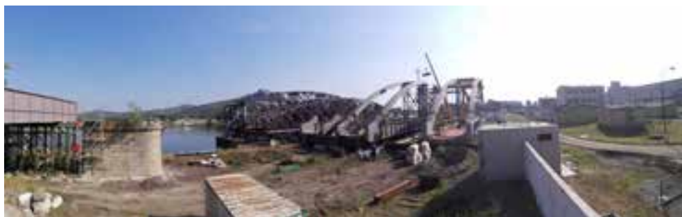
Obr. č. 4: Uložení 6 ks nosných ocelových konstrukcí na předmontážní ploše
