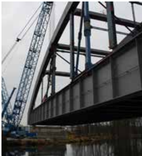
Most přes Nežárku
