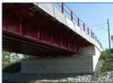
Obr. 14 Pohled na opěru mostu
