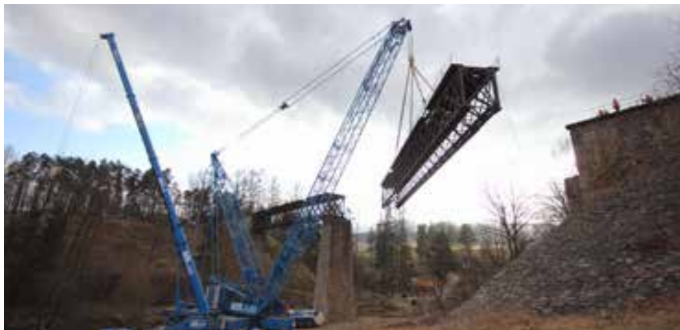
Obr. 4) Demontáž stávajících ocelových konstrukcí mostu
