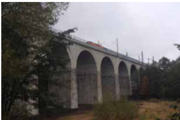
Obr. 8 - Pohled na dokončený most
