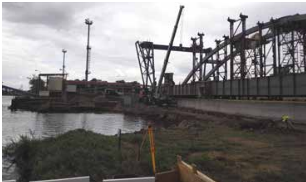
Obr. č. 2: Staveništní přístav - beranění štětovnic
