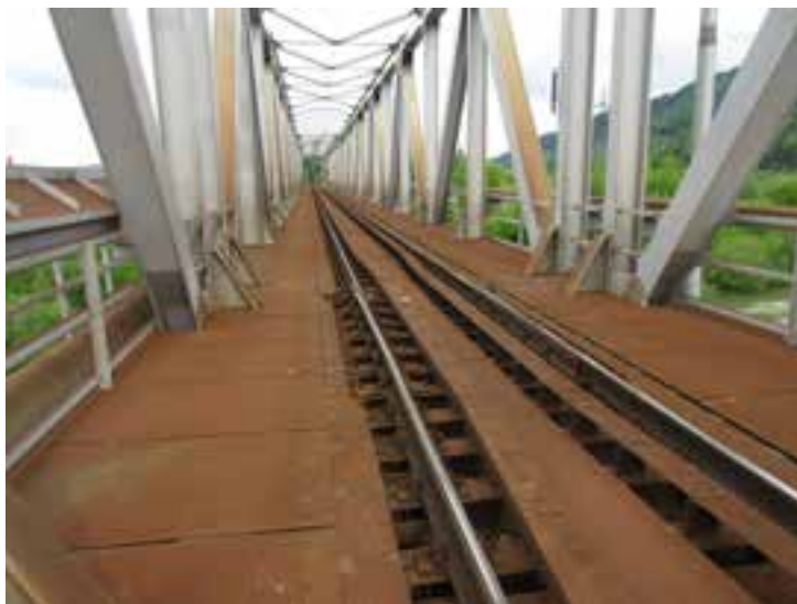
Obr. 10 – Most přes řeku Váh v km 5,230 u Žiliny
