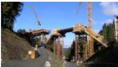
Obr. 2c: Podpěry a nosníky na mostě Grubental
