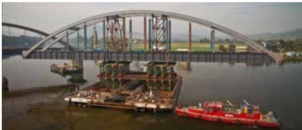
Obr. č. 11: Přesun NOK na pontonovém soulodí s vyztužením oblouku
