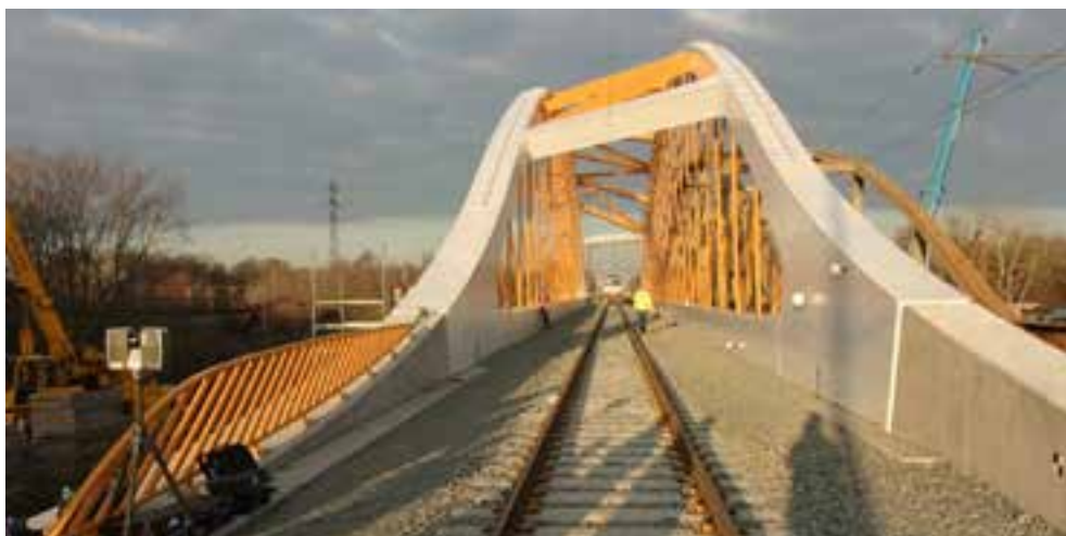
Obr. 3 – Dominantní portálové ztužení mezi oblouky, pohled do NOK1 směr Břeclav
