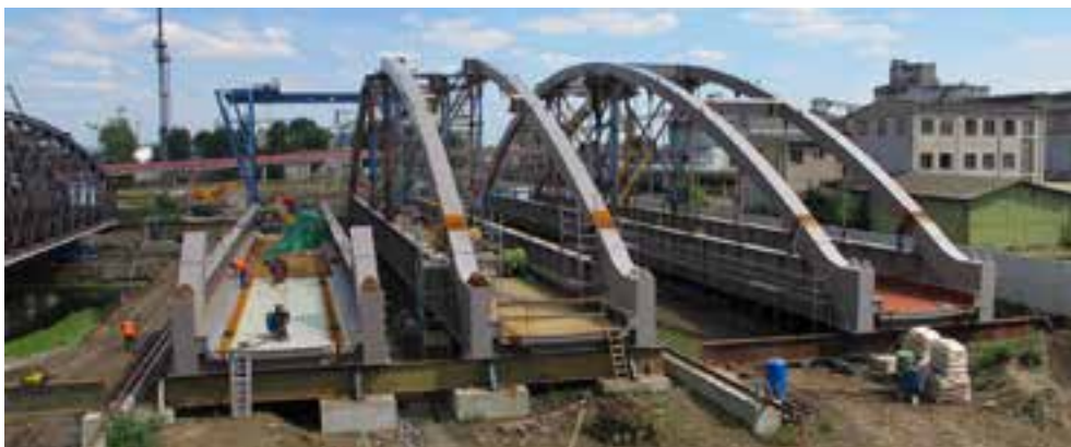
Obr. č. 8: Montážní a odstavná plocha zařízení staveniště mezi břehem řeky Labe a protipovodňovou ochranou závodu Lovosice
