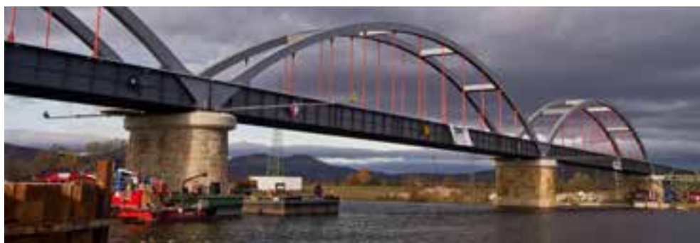
Obr. č. 14: Pohled na hotové mostní pole přes Labe
