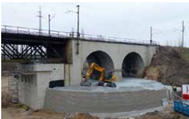
Obr. 7 Železniční most přes Úslavu: hlubinné zakládání pod stávajícími klenbami, násyp z vyztužené zeminy v prostoru kleneb
