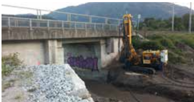
Obr. 1 Rozšiřování podjezdu za plného provozu
