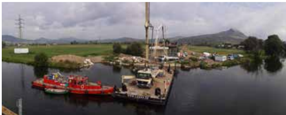
Obr. č. 5: Betonáž úložného prahu návodního pilíře
