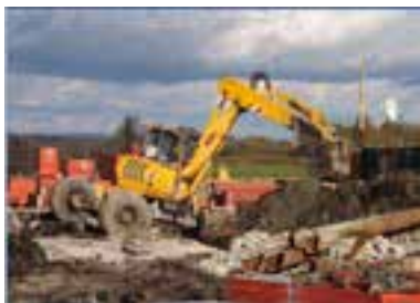
Obr. 3 Odtěžování zemin v jímce
