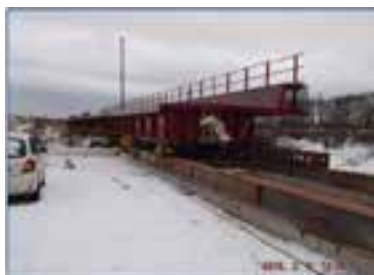
Obr. 10 Montážní plocha při výsunu
