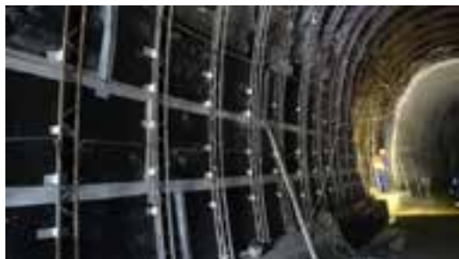
Obr. 4 Rubová hydroizolace a výztuž vestavby
