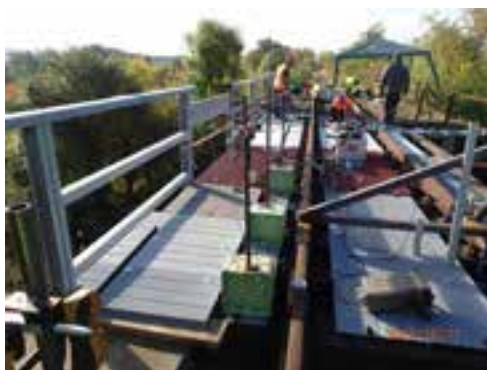
Obr. 4 Pohled na zatěžovací zkoušku zábradlí, zatěžovací přípravek, snímače vodorovné deformace.
