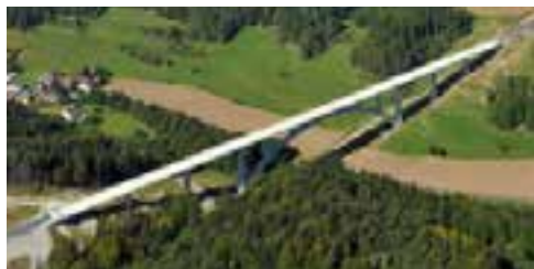
Obr. 5a,b Most Truckenthal (Foto: Nürnberg Luftbild, Hajo Dietz)
