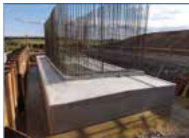
Obr. 6 Armokoš základu opěry
