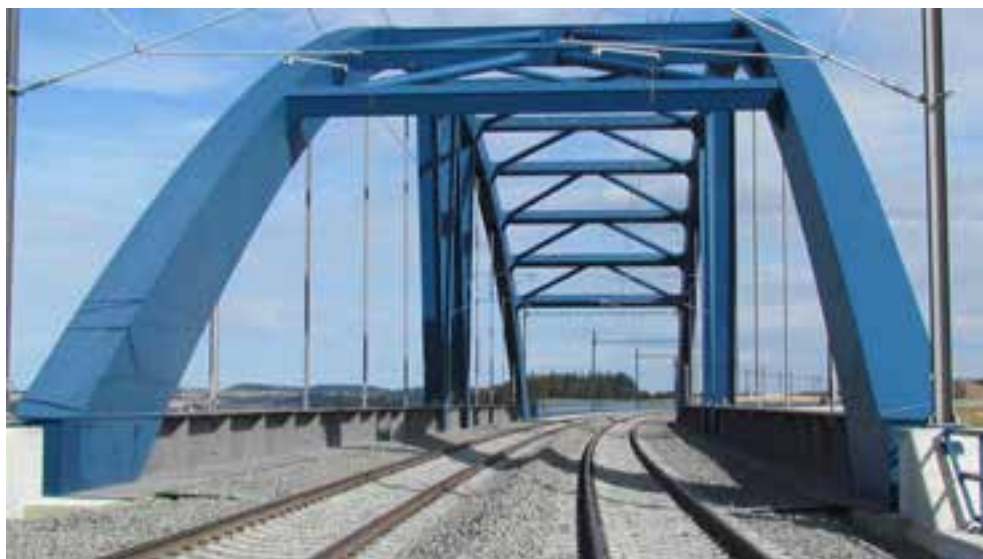
Podkladem pro hlavní prohlídku mostu v TÚ 1701 km 91,518 byla podrobná prohlídka
