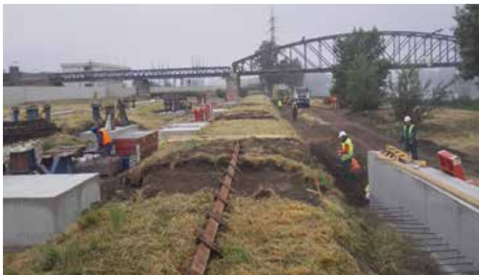
Obr. č. 1: Výstavba základových patek a jeřábové dráhy
