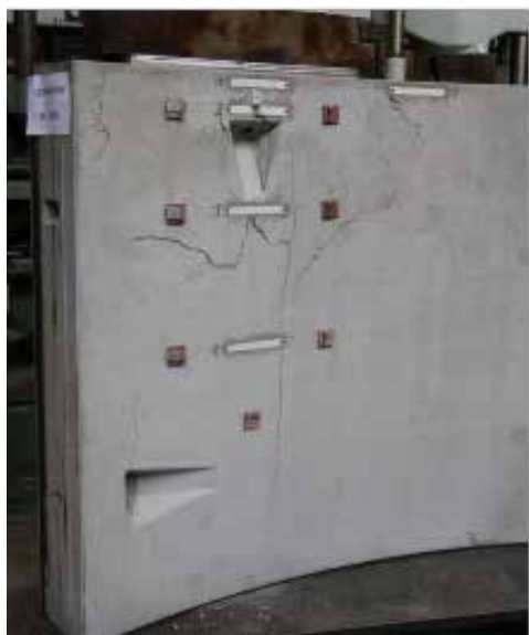
Obrázek 10: Porušený dílec segmentového ostění
