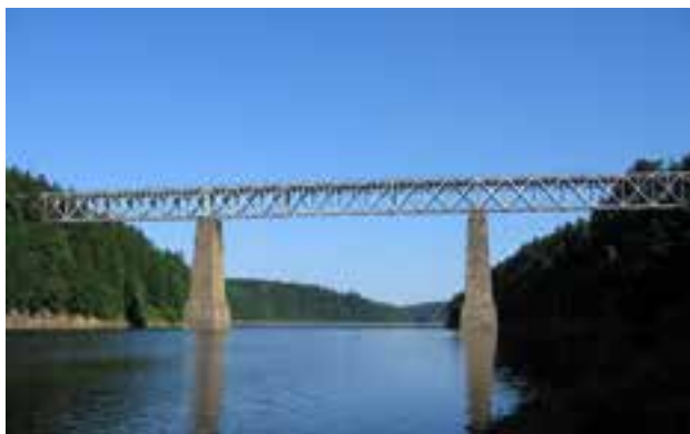
Obr. 1 Severní pohled na most v km 41,791 trati Tábor-Písek po proudu řeky Vltavy
