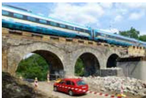
Obr. 3 Most přes Potoční ulici: pažení v koleji č. 2; zatěžovací zkouška v koleji č. 1
