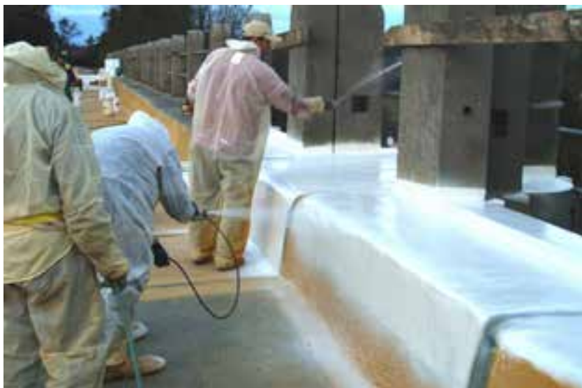
Obr. 4 – prováděné celoplošné stříkané izolace Eliminátor v místě dilatační spáry
