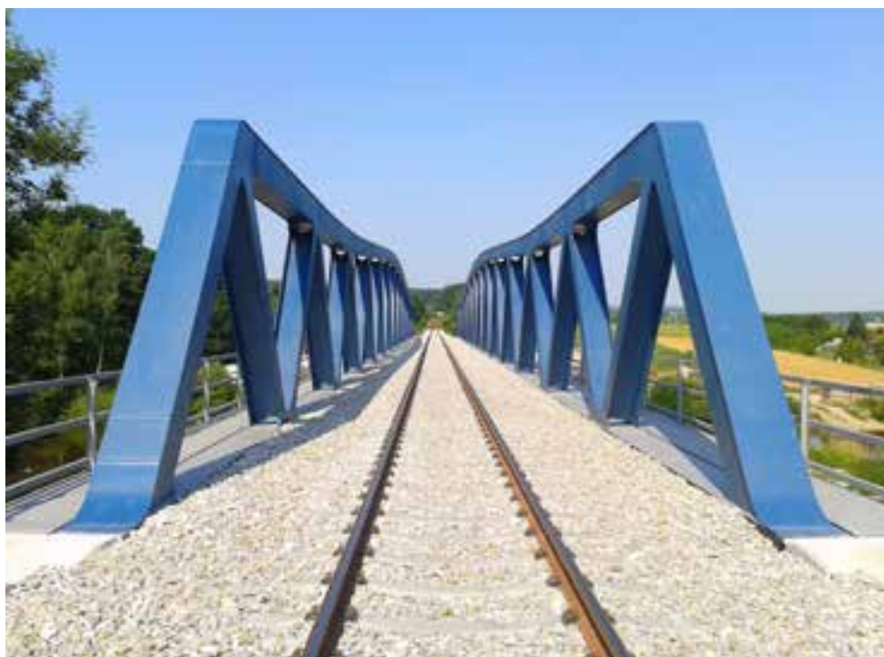
Obr. č. 8: Dokončený most
