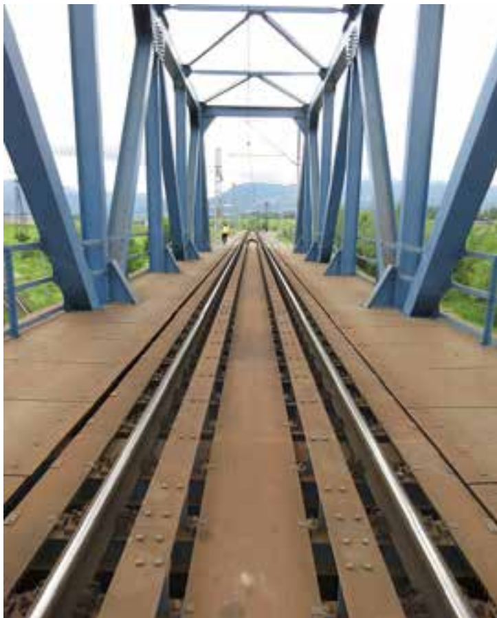
Obr. 12 – Most přes řeku Váh v km 4,678 u Žiliny
