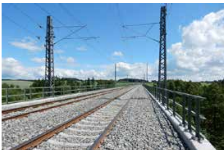
Obr. 9 - Pohled na dokončený most
