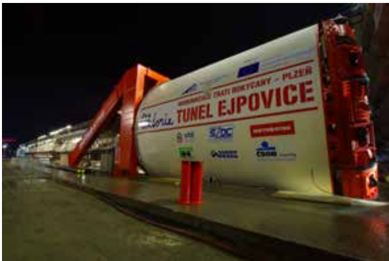
Obr. 6 Foto tunelovacího stroje před ražbou
