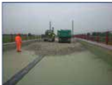
Obr. 12 Navážení štěrku na stříkanou izolaci
