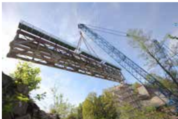
Obr. 7) Montáž nových ocelových konstrukcí mostu
