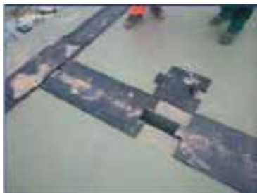
Obr. 11 Krytí podélné spáry mezi mosty
