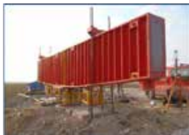
Obr. 2 Zatěžovací zkouška mimosystémové piloty
