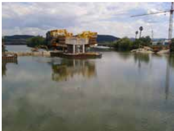
Obr. č. 2 vahadlo P5 a přístupový násep
