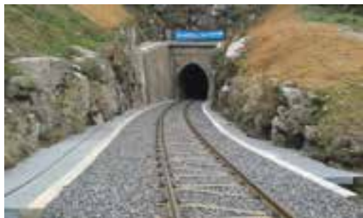
Obr. 2 Pohled na vjezdový (Kořenovský) portál
