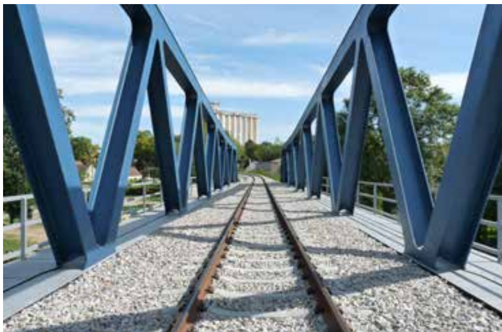
Obr. č. 2: Pohled ve směru staničení
