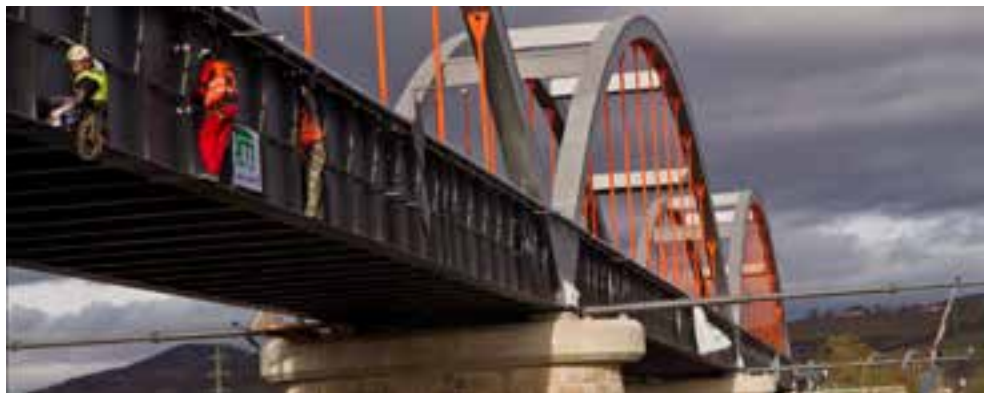
Obr. č. 12: Dokončovací práce - finální náěr mostu
