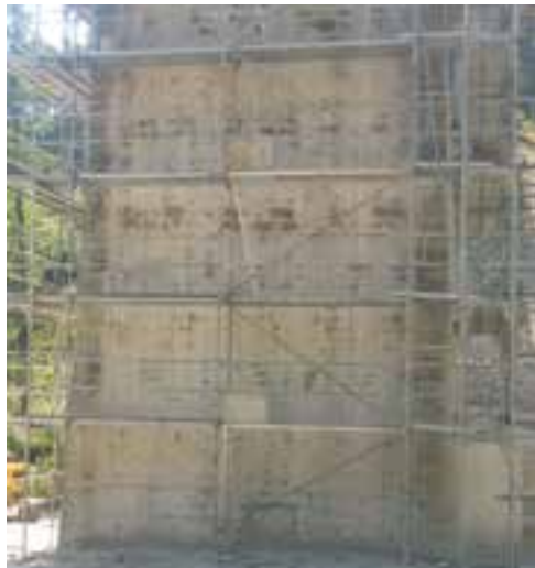
Obr. 8,9) Sanace spodní stavby
