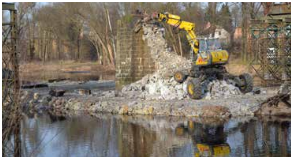
Obr. č. 4: Bourání středového pilíře
