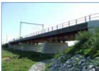
Obr. 13 Pohled na dokončený most
