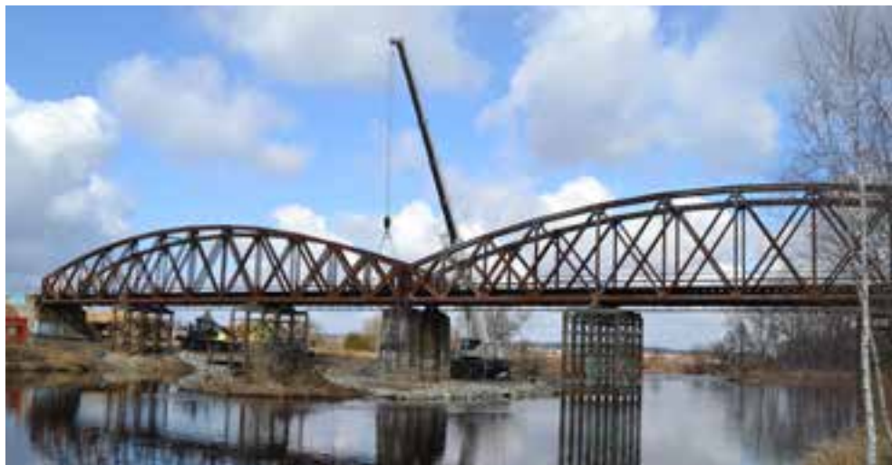
Obr. č. 3: Demontáž SOK
