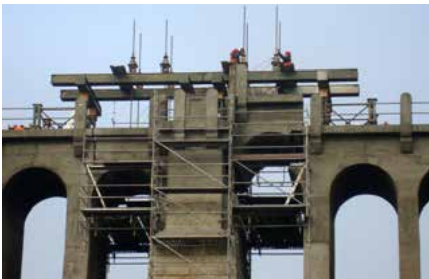
Obr. 3 – spouštění vložených polí
