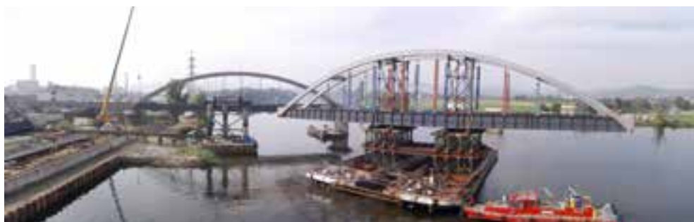
Obr. č. 6: Montáž nové ocelové konstrukce pole č. 5
