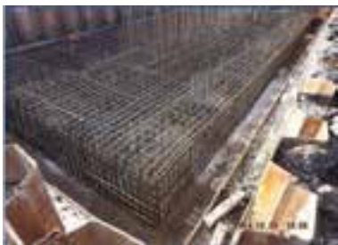
Obr. 5 Armokoš základu podpěry.
