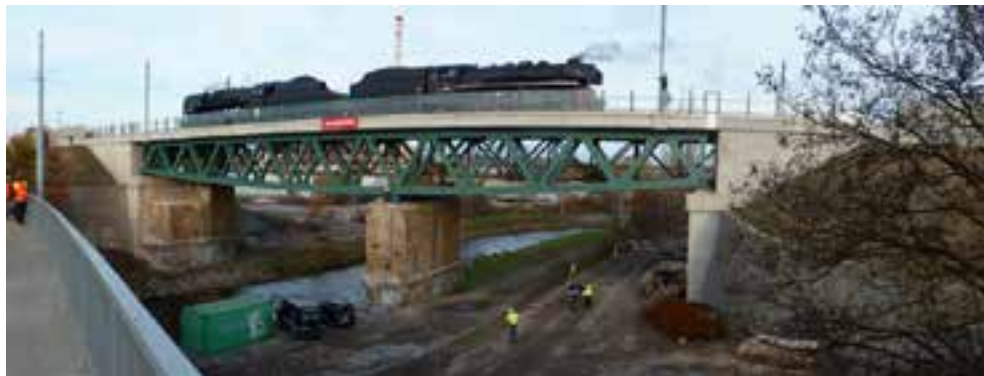
Obr. 8 Železniční most přes Úslavu: osazení montážních dílců nosné konstrukce; nosná konstrukce v koleji č. 1 při zatěžovací zkoušce
