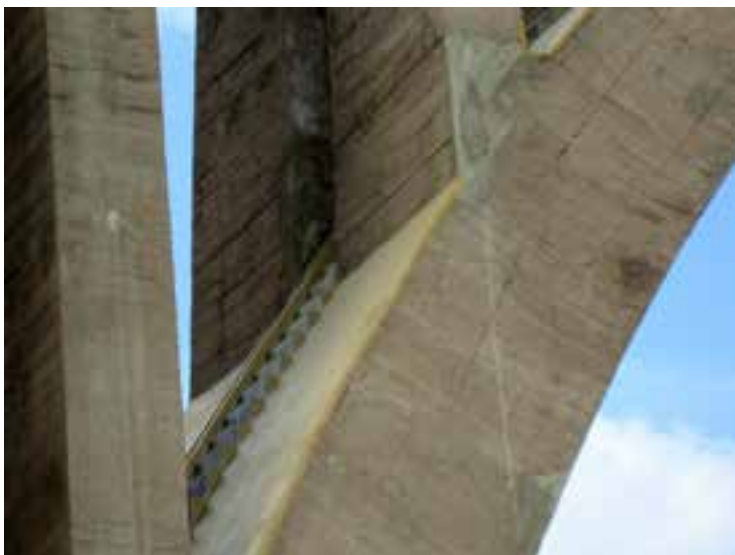
Obr. 6 – pohled na oblouk po sanaci, patrný nátěr rubu, původní revízní schodiště a odvodňovací žlab
