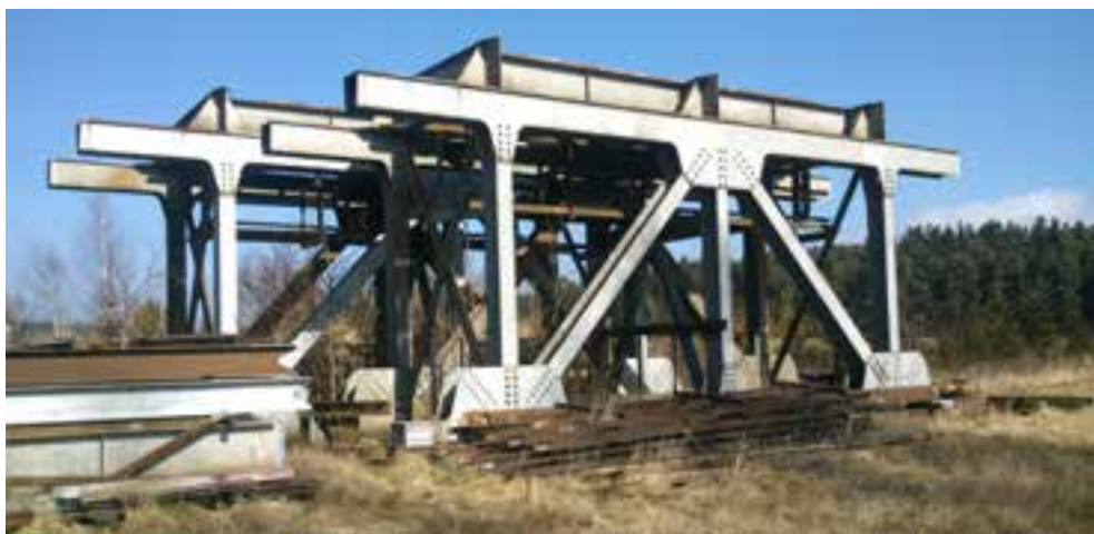
Obr. 2) Uložiště vyzískané konstrukce
