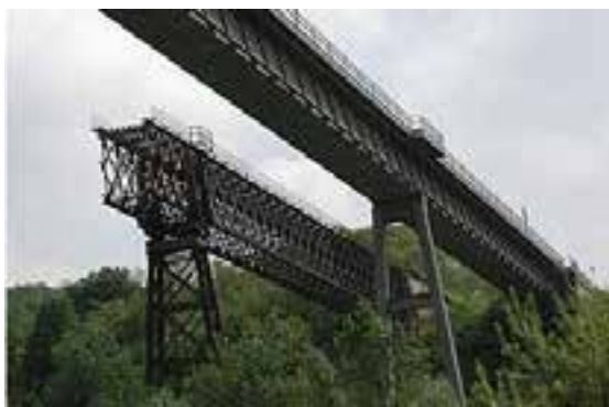
Obr.1 Ivančické viadukty - torzo původního a část nového mostu
