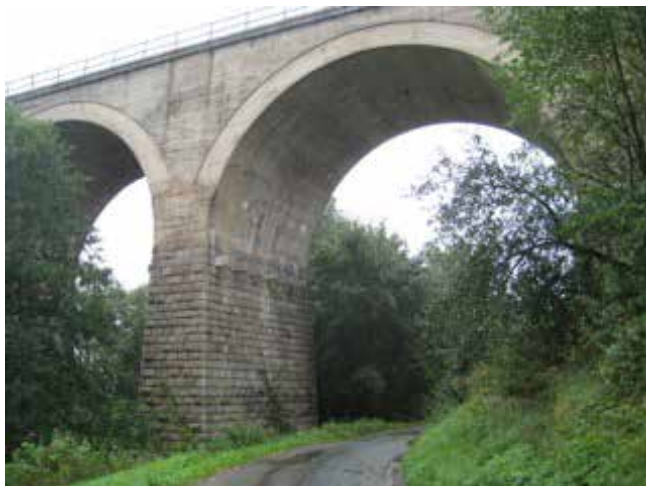
Obr. 1 - Původní stav mostního objektu
