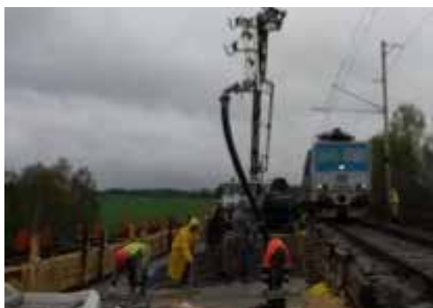
Obr. 4 – Betonáž ŽB desky
