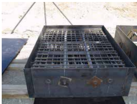
Obrázek 6: Zkušební dílec před betonáží
