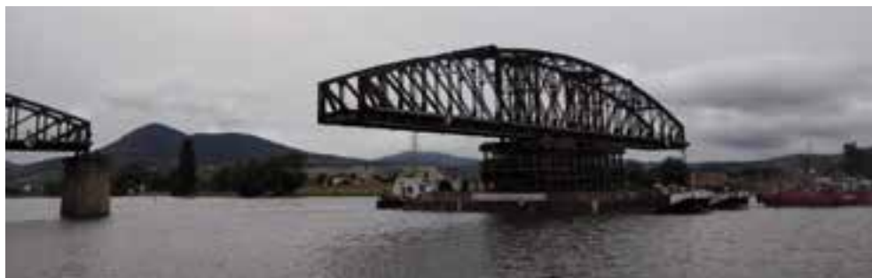
Obr. č. 3: Demontáž nosné konstrukce - 4. pole
