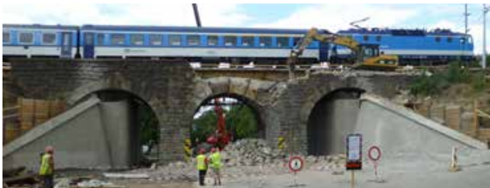
Obr. 5 Most přes Mohylovou ulici: princip zajištění provozované koleje; demolice za provozu v sousední koleji
