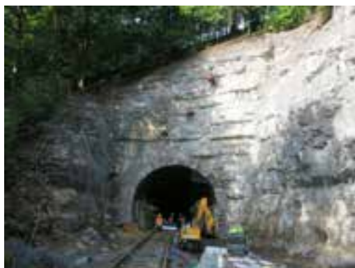
Obr. 3 Zajištění portálových stěn
