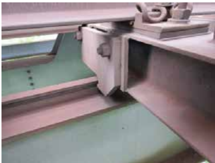
Obr. 11 – Detail upevnění ocelových mostnic na mostě přes řeku Váh
