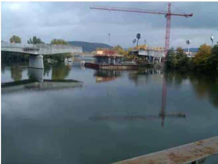
Obr. č. 3 podskružení zárodku na P6, vahadlo P7
