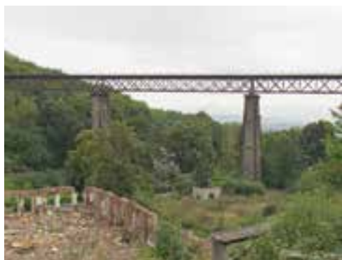
Obr. 5 úsek Most - Dubí km 143,500
