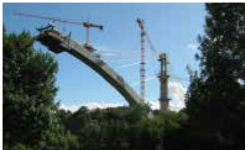
Obr. 4d,e: Letmá betonáž oblouku mostu Froschgrundsee
