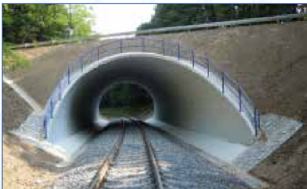
km 13,545 trati Chuchelná – Kravaře ve Slezku ( Bolatice ) Multi – Plate 9,96m x 6,20m
