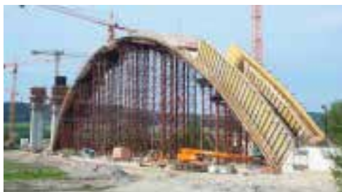
Obr. 1c: Les sloupků na mostě Ilmtal
