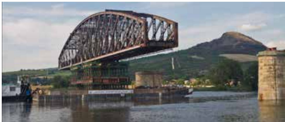
Obr. č. 10: Přesun SOK na pontonovém soulodí
