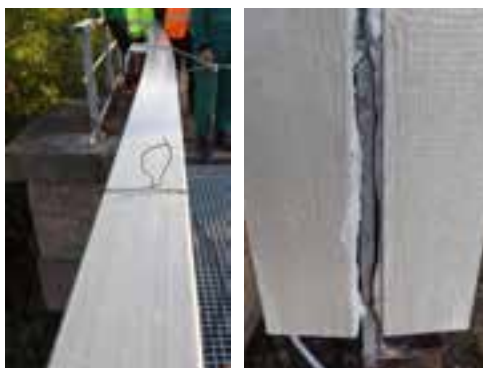
Obr. 5 Deformace a síla při zatížení zábradlí na mostě – madlo a panel, průhyb při zkoušce a porušení v lepeném styku
