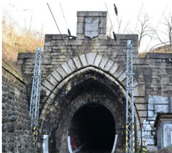
Obr. 4 – Pohľad na západný portál Bratislavského tunela so stredovým konzolovým žlabkom
