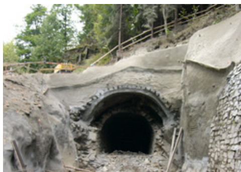
Obr. 6 – tunel Domašovský – budování nové hloubené portálové části
