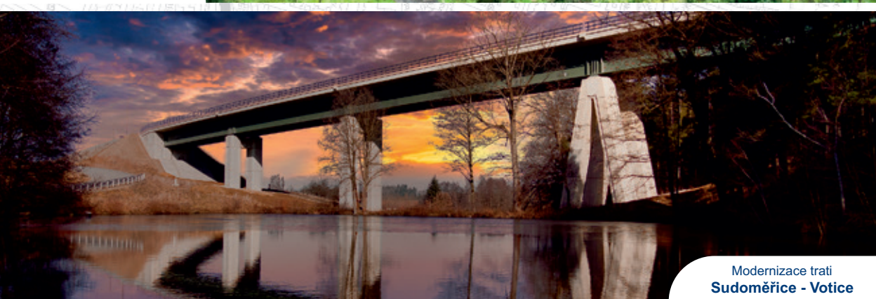
Rekonstrukce Vilémovského viaduktu
