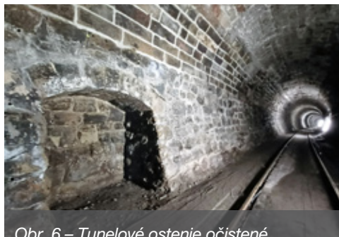
Obr. 6 – Tunelové ostenie očistené tlakovou vodou
