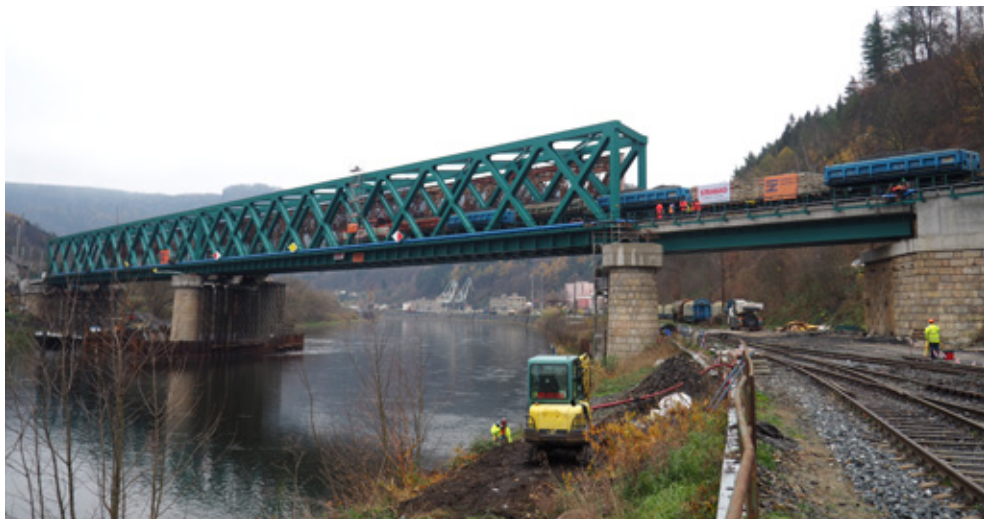
Obr. 6 – Statická zatěžovací zkouška – kritická poloha na nosné konstrukci NK1 (foto autor)
