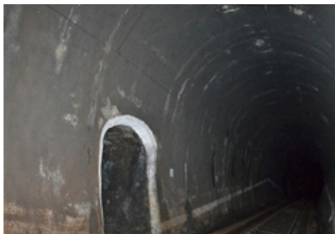
Obr. 5 – Tunelové ostenie s vrstvou torkrétu
