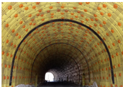
Obr. 4 – tunel Blanenský č. 10 – instalace fóliové izolace
