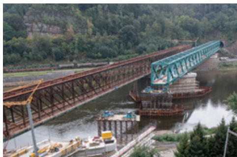
Obr. 10 Postupný podélný výsun NOK 2
