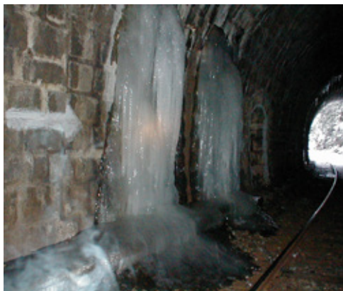
Obr. 1 a 2 – Harrachovský tunel – problémy se zatékáním
