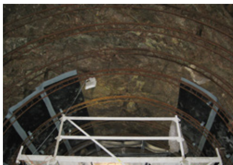
Obr. 3 – Harrachovský tunel – instalace izolace z HDPE desek
