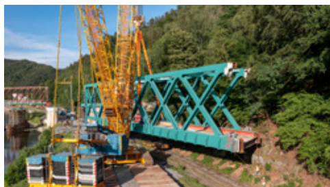
Obr. 9 – Transport NOK 2 pomocí jeřábu LIEBHERR LR 1750
