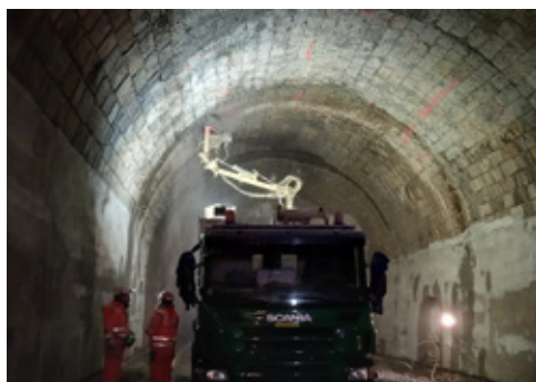
Obr. 5 – tunel Blanenský č. 9 – vyřezávání svodnic
