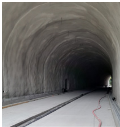
Obr. 3 – opravené dno tunelu č. 10
