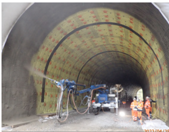
Obr. 2 – aplikace stříkaného betonu v tunelu č. 10
