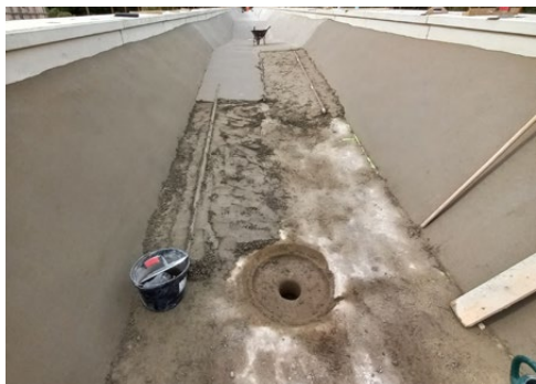
Obr. 3 – Podklad pro izolaci a odvodnění
