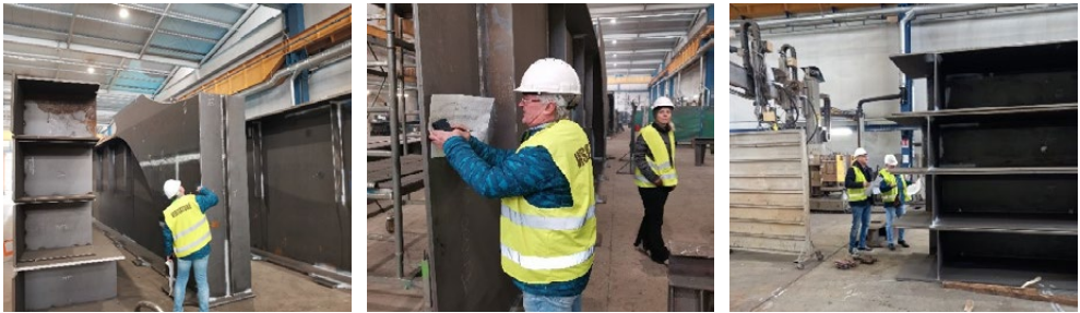
Obr. 5, 6, 7 – Kontrola kvality zvarových spojov na zárodku oblúka
