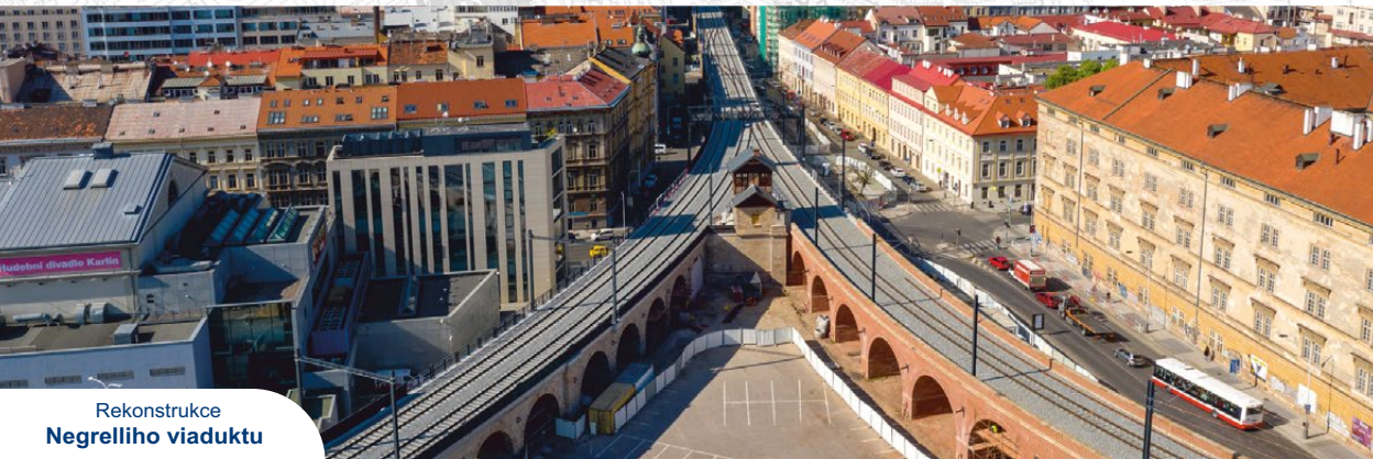
Modernizace trati Sudoměřice - Votice
