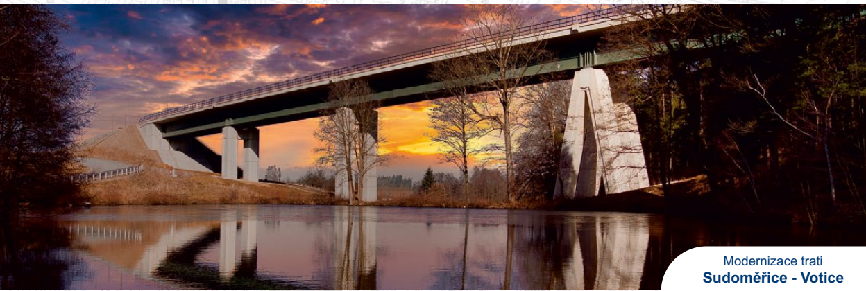
Rekonstrukce Vilémovského viaduktu
