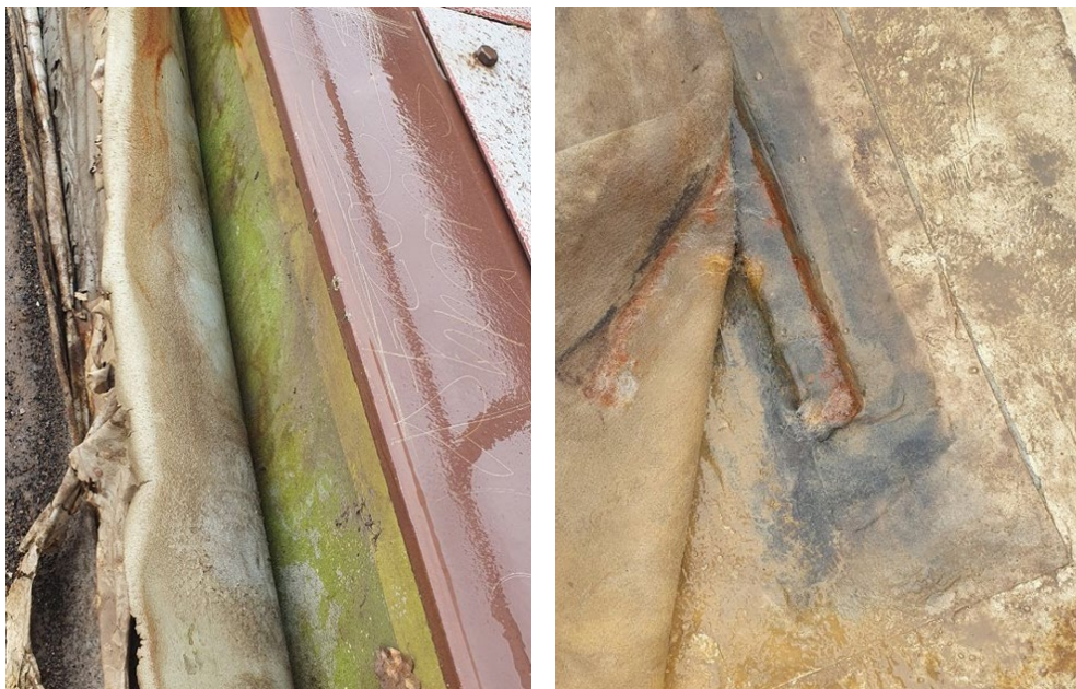
Obr. 8 a 9 – Delaminace na boku kolejového lože a prokorodování izolace v místě montážního oka
