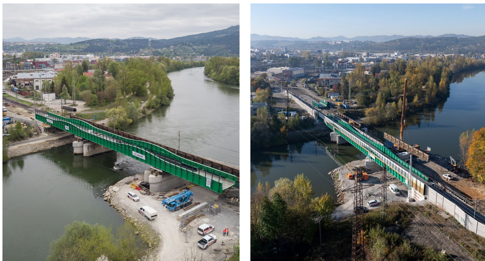
Obr. 3 – Rekonštrukcia mostov I. etapa
