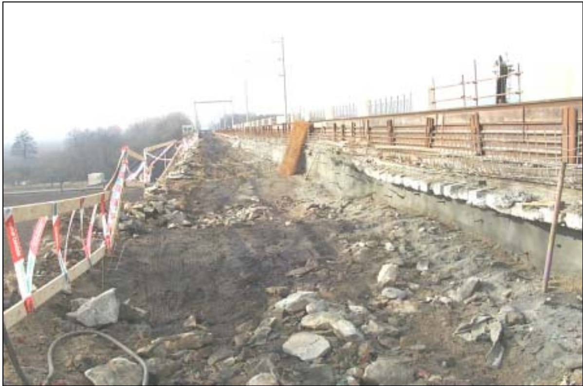
JVC – odtěžování nadnásypu
