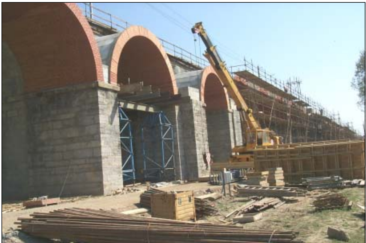
JVC – vybetonované klenby s pohledovým zdivem
