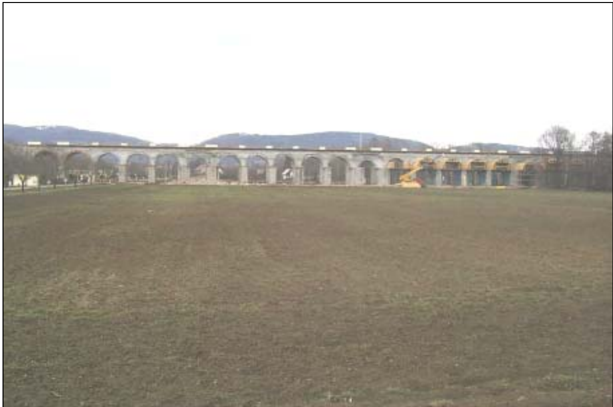
JVC – bourání starých kleneb, podskružování nových
