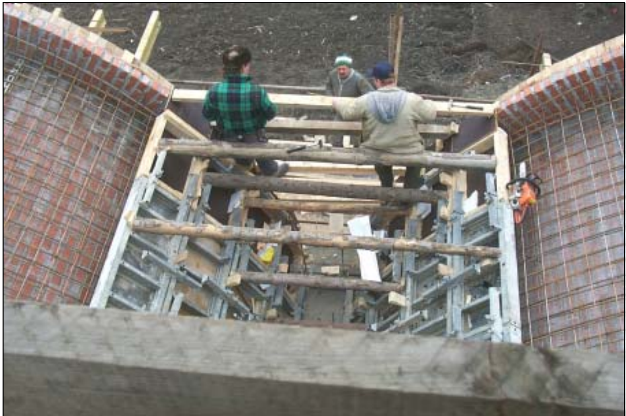
JVC – bednění žlb kleneb
