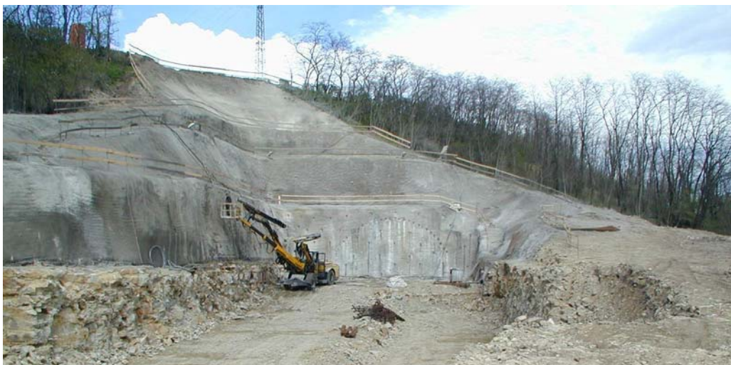
Obr. 5: Pražský portál – dotěženo na úroveň dna kaloty
