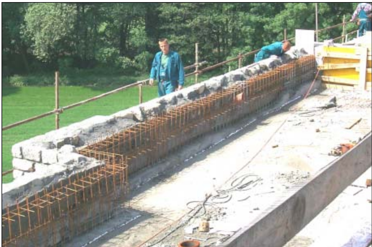
JVC – vyzdívání průčelních zdí a armování žlb stěny
