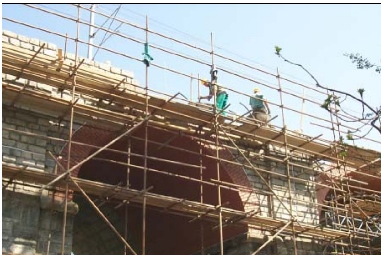
JVC – vyzdívání průčelních zdí
