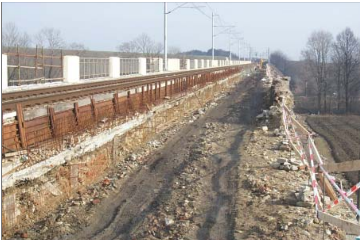
JVC – zajištění provozované koleje
