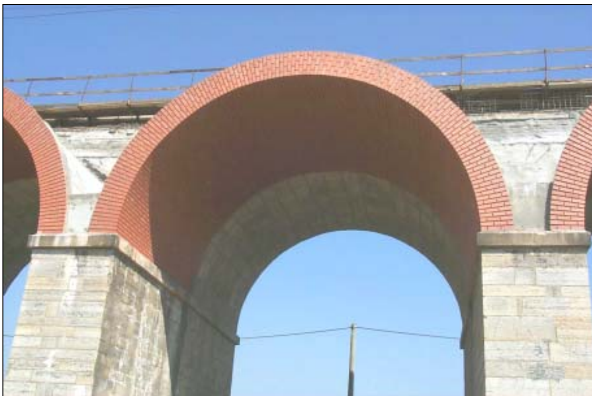
JVC – vybetonovaná klenba s pohledovým zdivem
