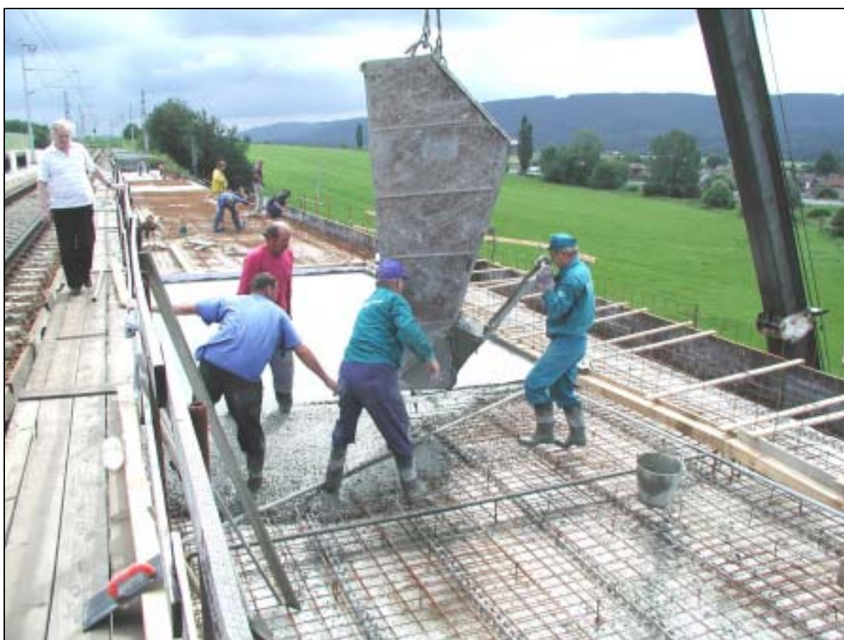
JVC – armování a betonování nasazené desky
