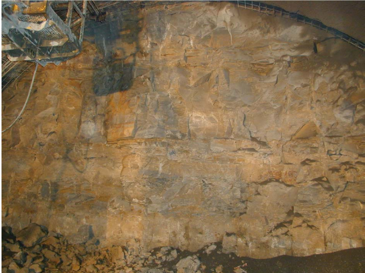
Obr.1: Čelba kaloty ve staničení TM 77,00:
