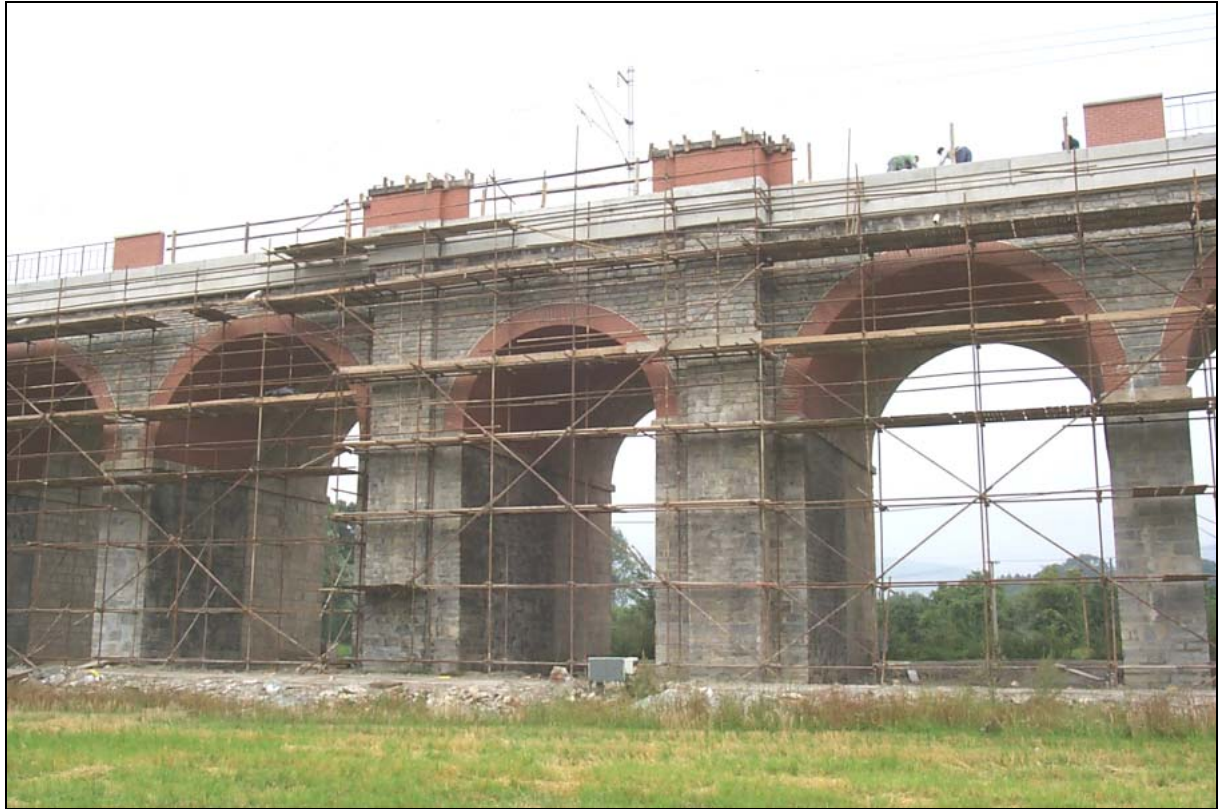
JVC - vyzdívání a osazování zábradelních pilířků
