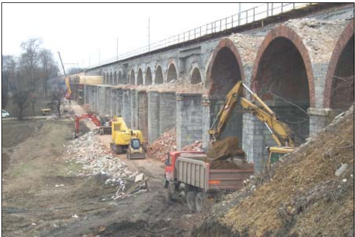
JVC – bourání starých kleneb, podskružování nových
