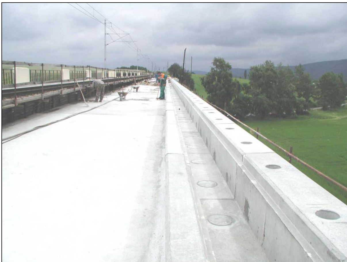
JVC - monolitická nasazená deska s prefabrikovanou římsou
