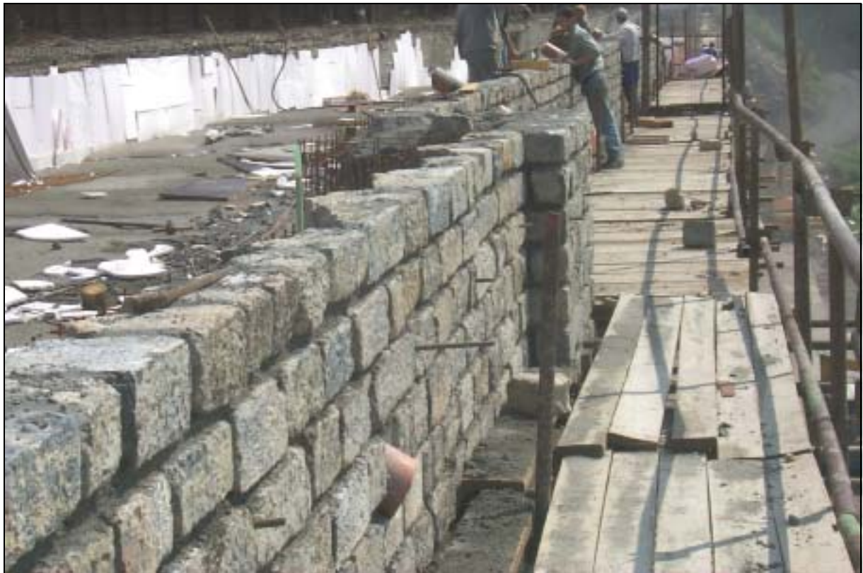
JVC – vyzdívání průčelních zdí
