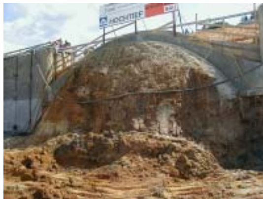
(obr. č.6) želva, tunel Euerwang – Nord
