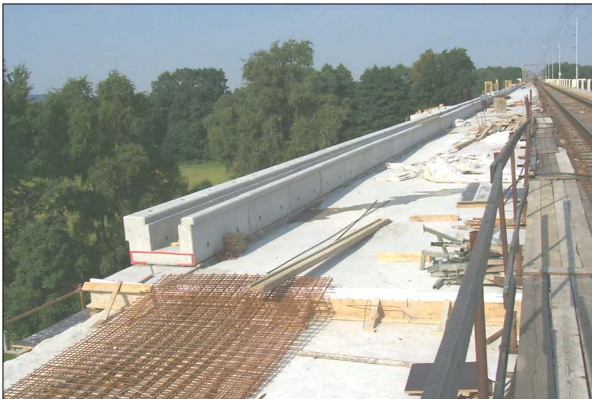
JVC - osazování římsových prefabrikátů
