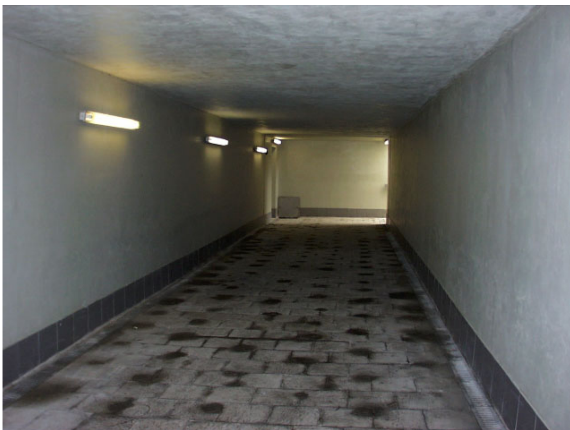
obrázek č. 4 podchod v Podivíně (TÚ:2001, km:94,153)
