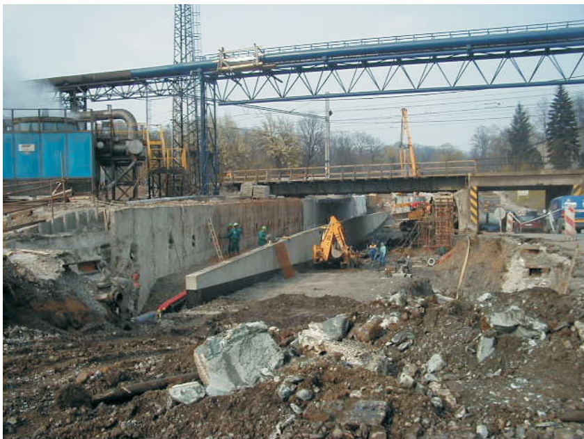
Výstavba v otvoru pod MP
