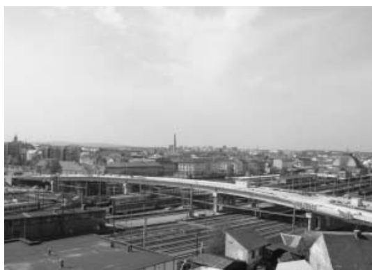
celkový pohled na most
