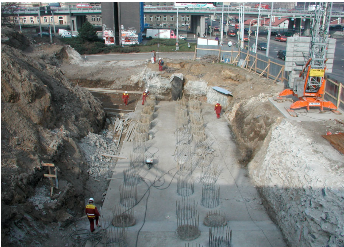
18.3.2002 Opěra „Praha hl.n.“ – piloty, podkladní beton pod základový pas
