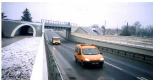
Obr.2.1 Profil klenbový (vlna 150×50 mm) a rámový (vlna 380×140 mm), Prudnik (Polsko)
