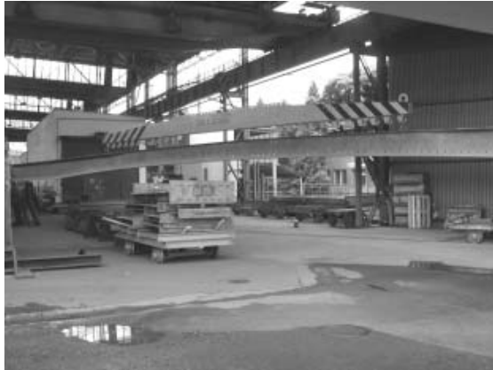
manipulace s nosníky v mostárně
