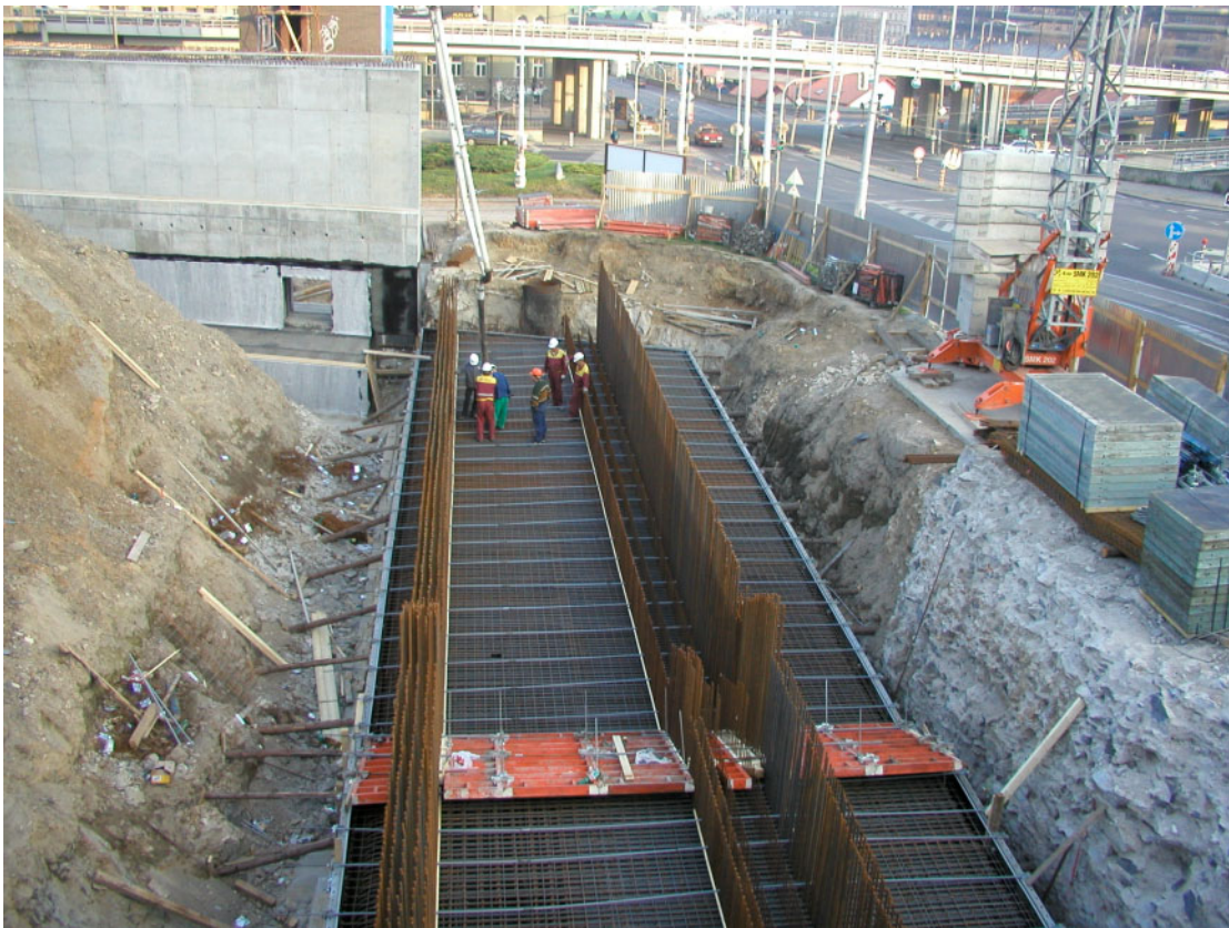
5.5.2002 Opěra „Praha hl.n.“ – armování základového pasu a stěn skříňové opěry
