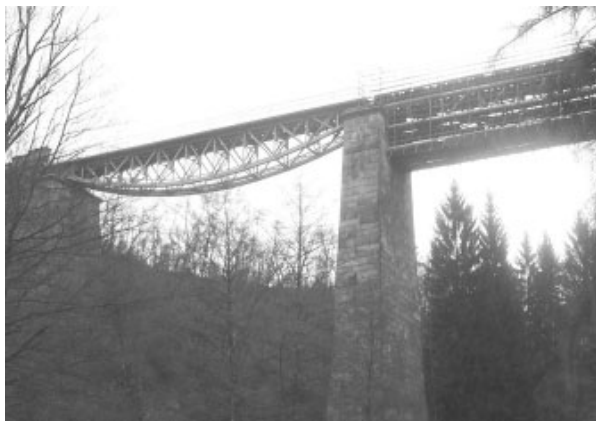
Zima 2002-opravené 1. pole a lešení v 2. poli
