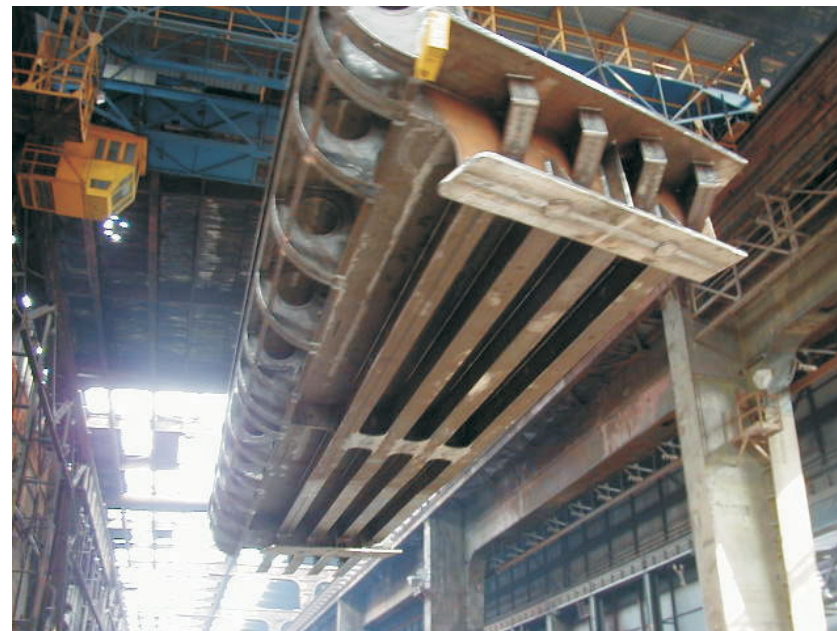
Část OK na jeřábu 2
