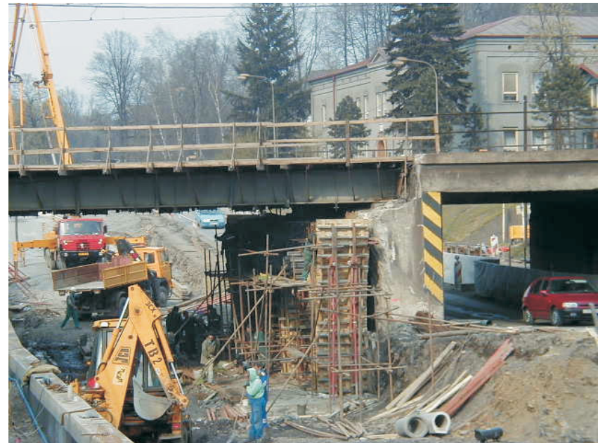
Bednění pilíře Žel. mostu
