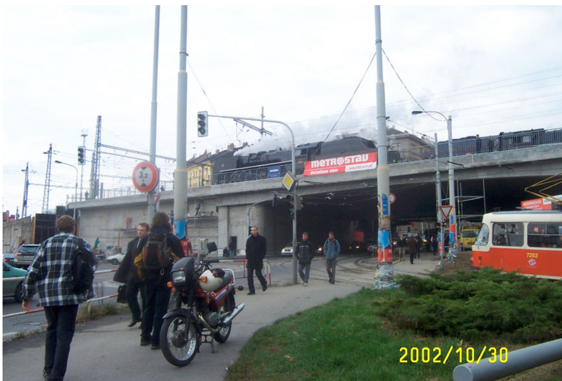
30.10.2002 Opěra „Praha hl.n.“ – most 14 dní před otevřením, zatěžovací zkouška
