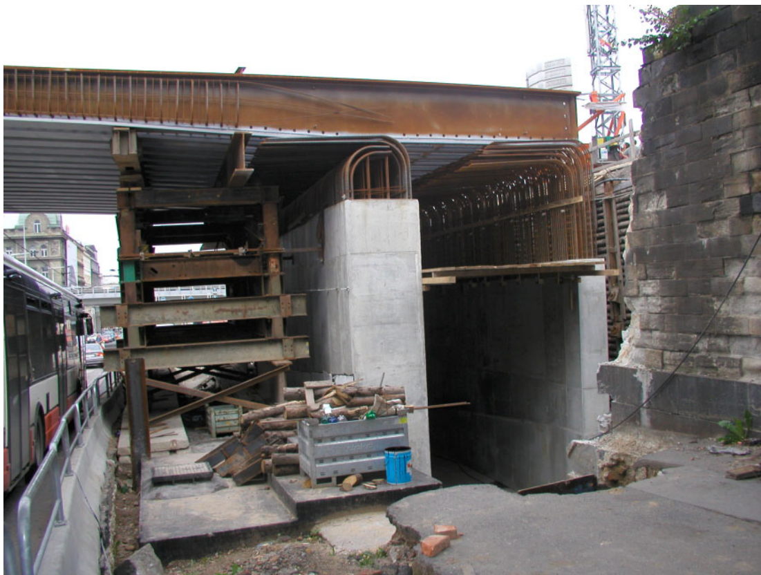
20.8.2002 Opěra „Praha hl.n.“ - svařované nosníky před spuštěním do definit. polohy
