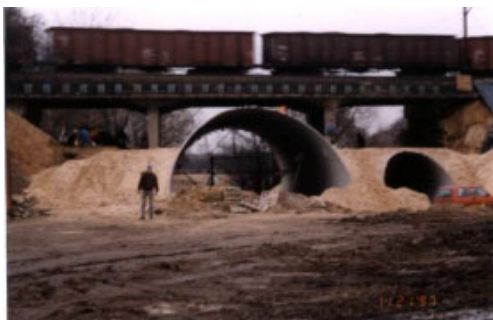
Obr. 3.2 Zásyp a hutnění konstrukcí pod původním betonovým mostem
