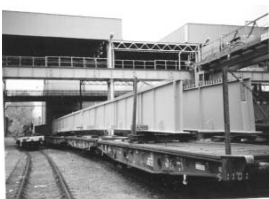
přeprava nosníků po železnici
