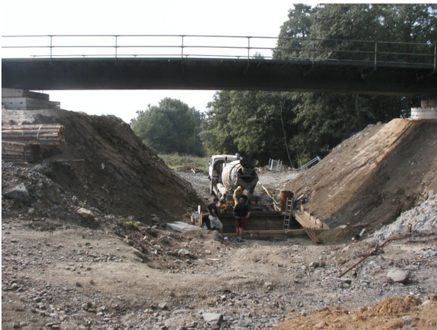
betonáž základu pod provizorii
