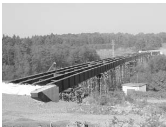
pohled na smontovanou konstrukci
