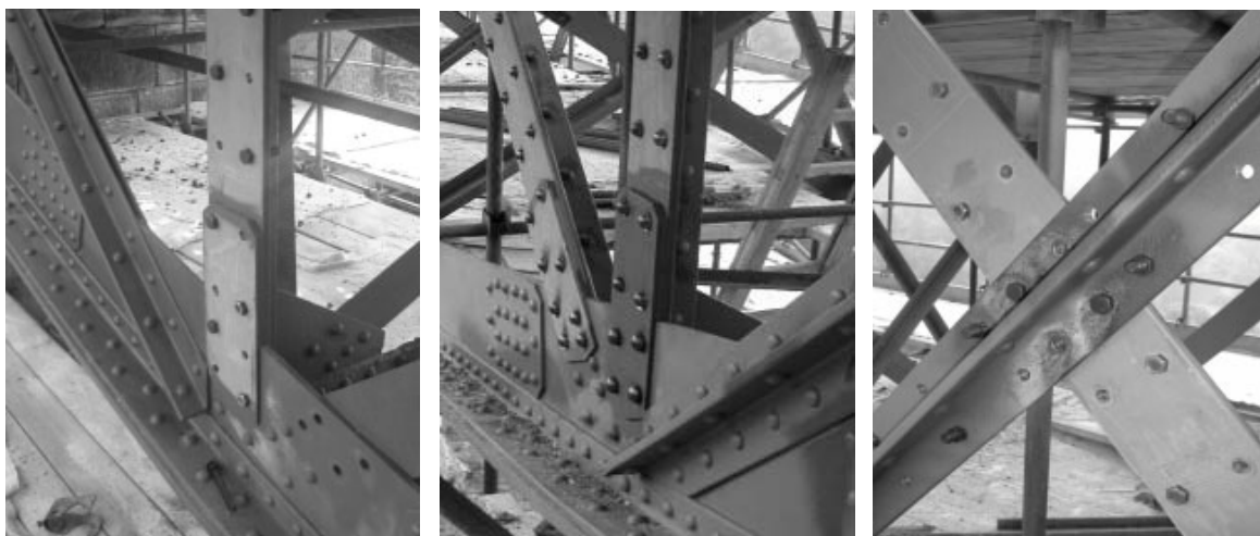
Detaily zesílení diagonál a svislic hlavního nosníku
