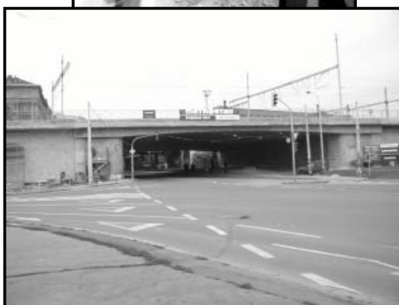
Pohled směrem od Bulhara – 11/2002
