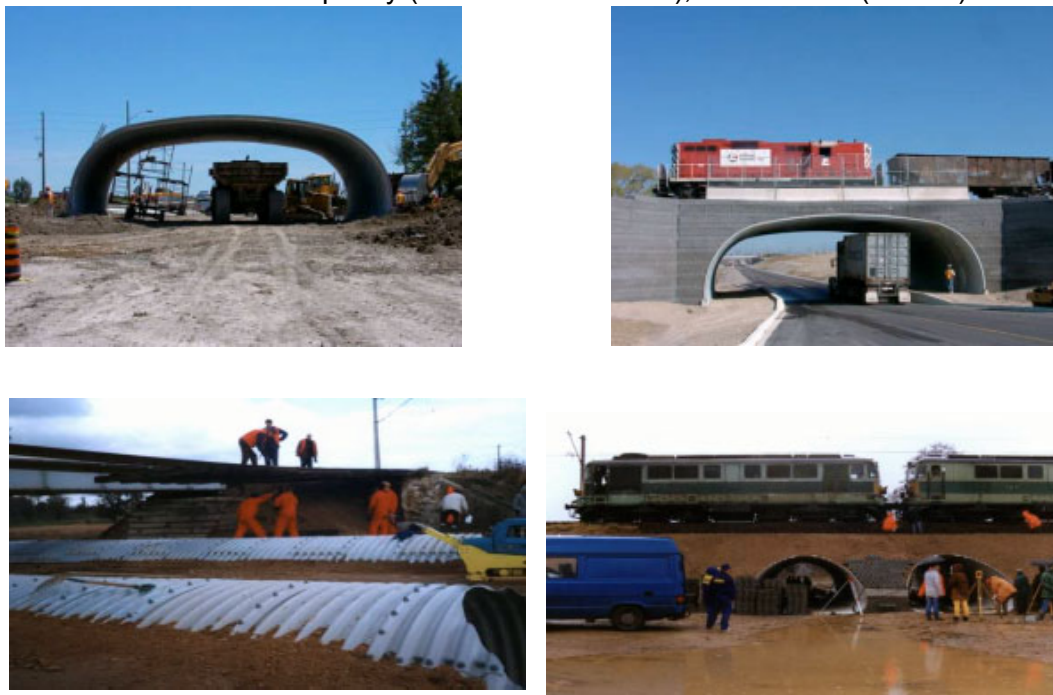
Obr. 2.3 Profil rámový (zvlnění 380×140 mm), Kanada
