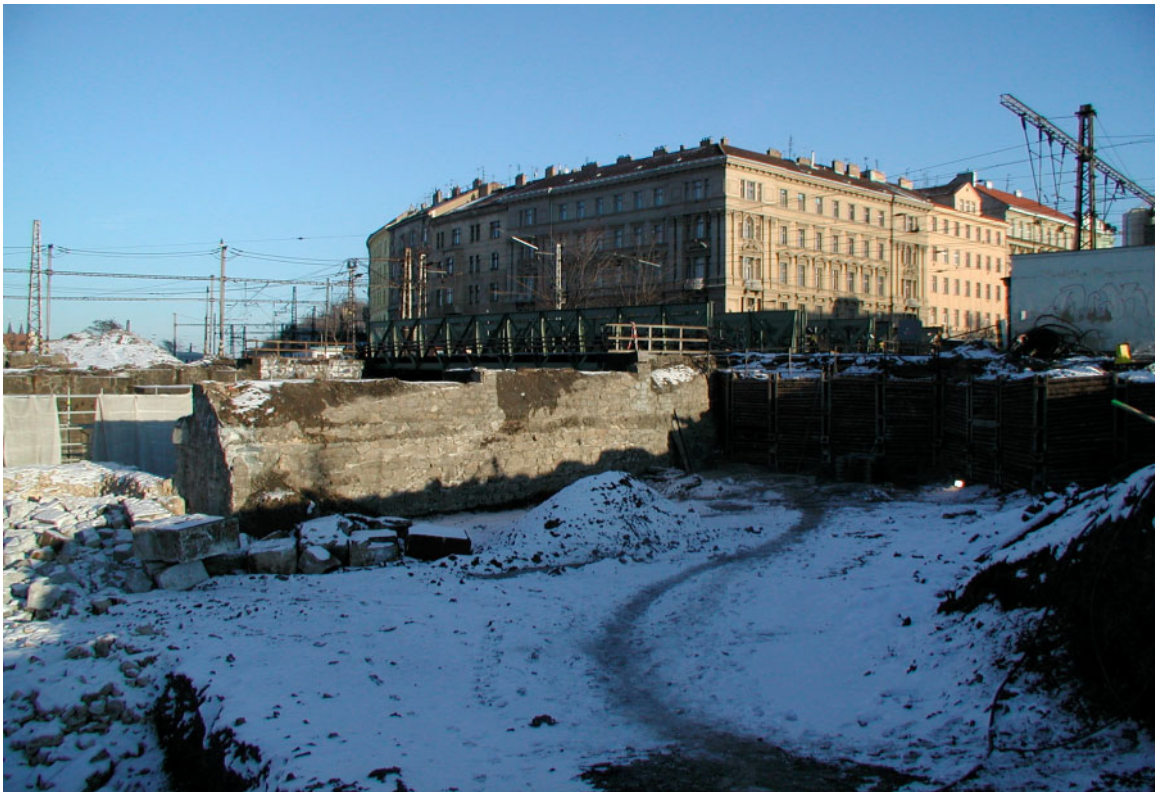
3.1.2002 Opěra „Praha hl.n.“ – zajištění provozované koleje, hloubení jámy
