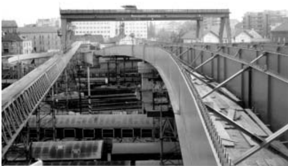
montáž nosníků pomocí portálového jeřábu
