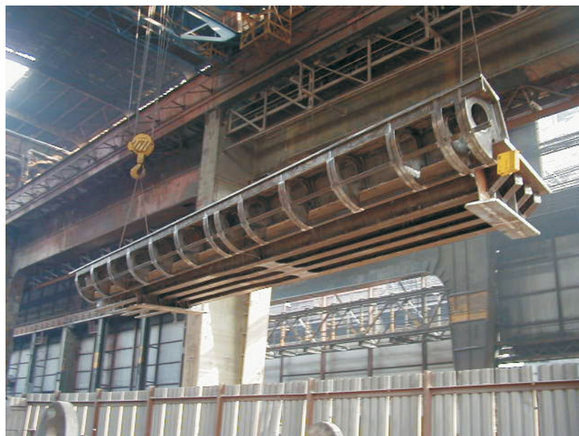
Část OK na jeřábu 3
