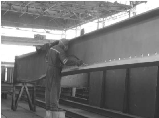
aplikace nátěru na dolní pásnici nosníku
