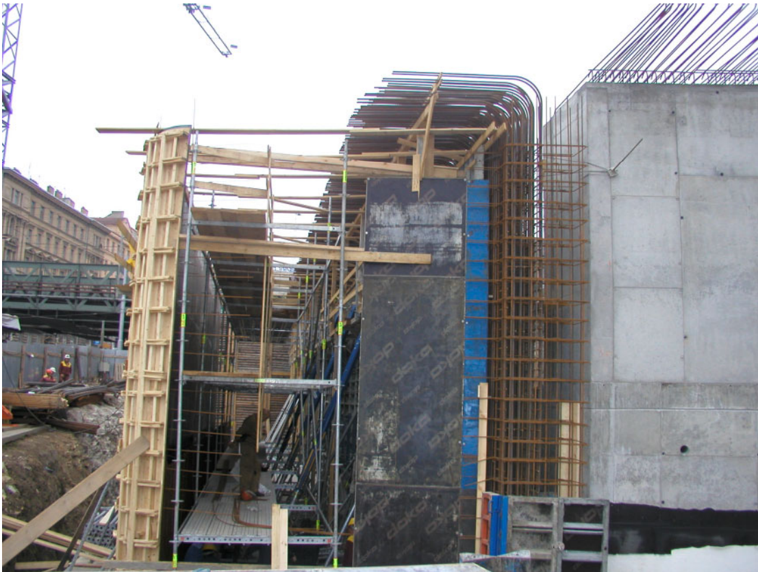
28.5.2002 Opěra „Praha hl.n.“ – vybetonovaný základový pas, bednění stěn opěry
