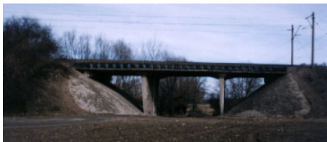
Obr. 3.1 Pohled na původní betonový most
