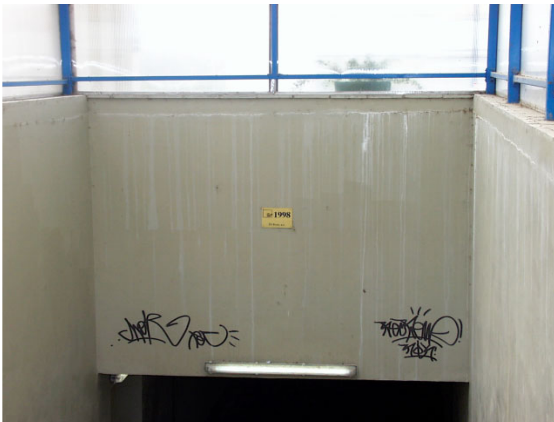
obrázek č. 3 podchod v Modřicích (TÚ:2001, km:94,153)
