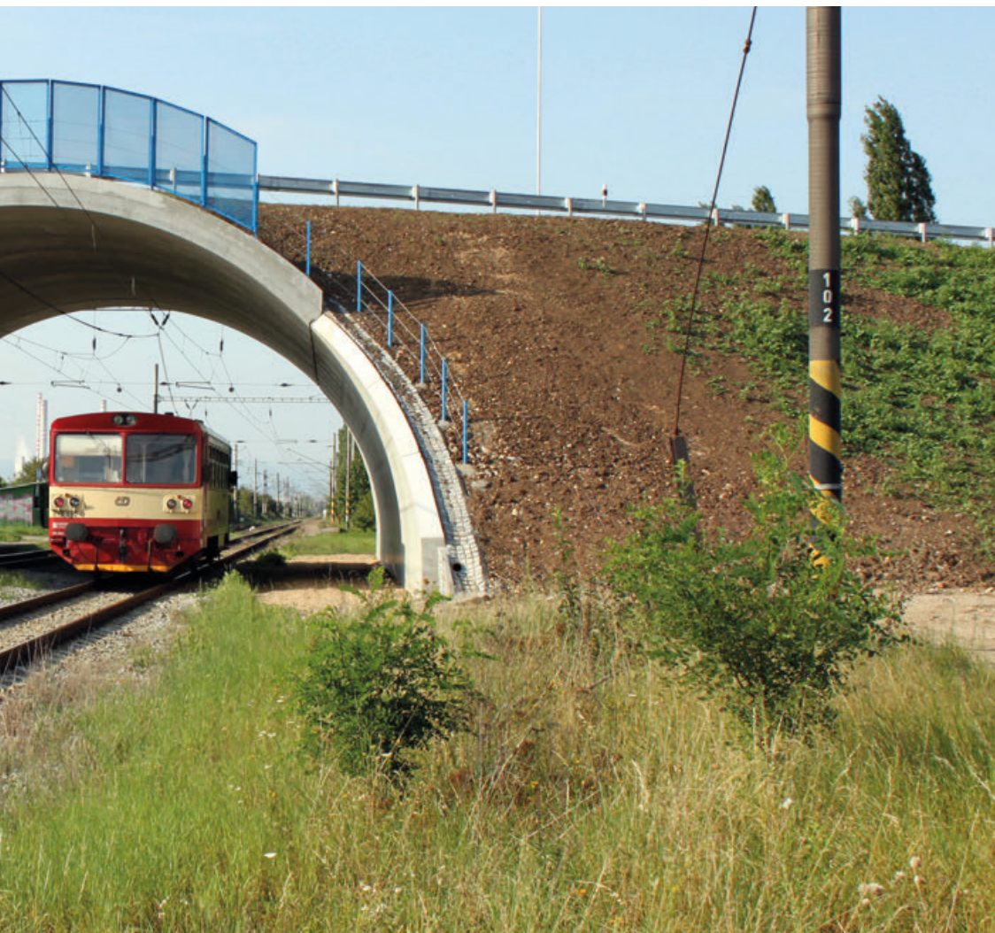
Nový nadjezd u obce Výškov v Čechách, hotový bezúdržbový most
