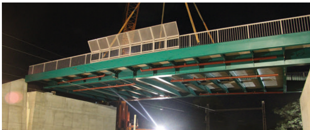
Nový nadjezd nad žel. koridorem u obce Ladná, celek osazen vč. bednění a odvodňovačů
