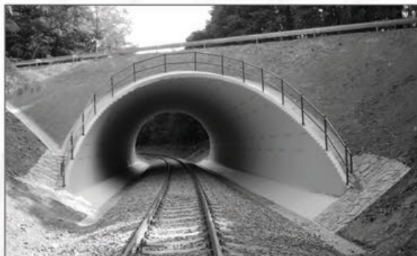
km 13,545 trati Chuchelná – Kravaře ve Slezsku ( Bolatice ) Multi – Plate 9,96m x 6,20m
