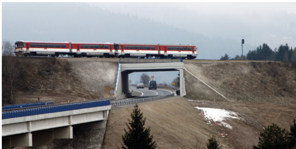
Nový podjezd rychlostní silnice R3 u obce Horná Štubňa, Slovensko
