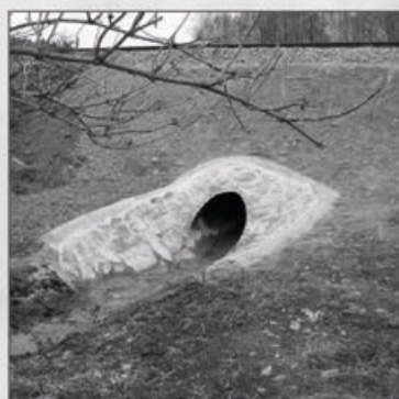
km 34,224 trati Svítavy–Žďárec u Skutče Hel-Cor Trenchcoat DN800
