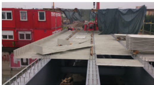
Nový nadjezd nad žel. koridorem u obce Ladná, celek osazen vč. bednění a odvodňovačů
