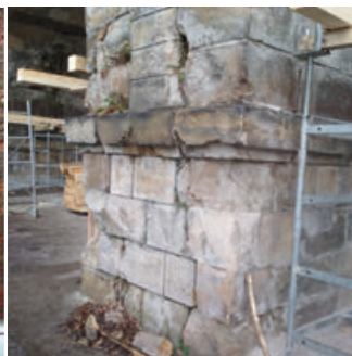
Obr. 4, 5 –poruchy zdiva
