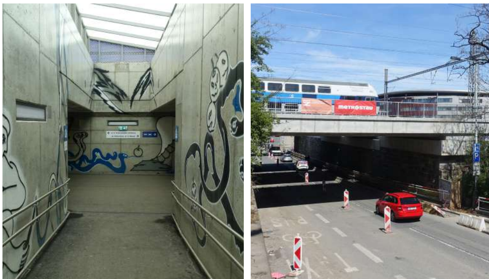
Obr. 4 Mostní objekty v lokalitě Praha Eden: podchod; most přes ulici U Vršovického hřbitova
