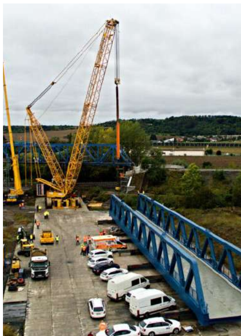
Obr. 15 Demontáž konstrukce pomocí jeřábu
