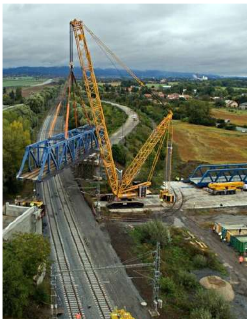
Obr. 15 Demontáž konstrukce pomocí jeřábu
