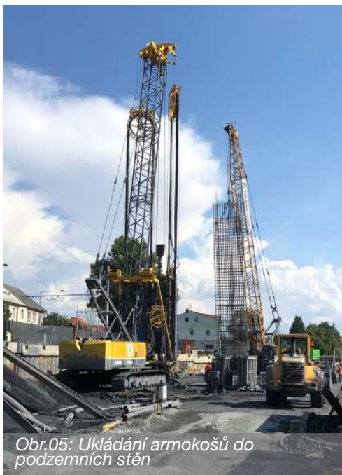
Obr.06: Ukládání armokošů do podzemních stěn
